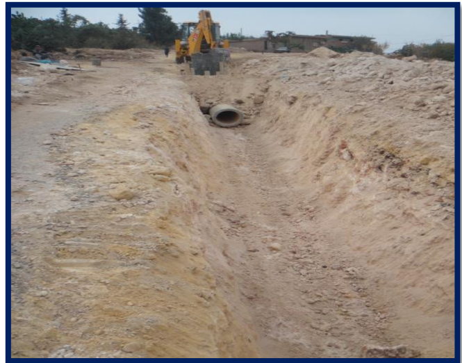
Figure VIII-4: Pose de la canalisation sur terrain. Source : Google.
