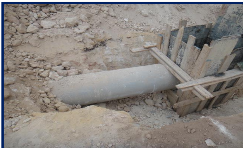
Figure VIII-6: Regard au cours de réalisation.
