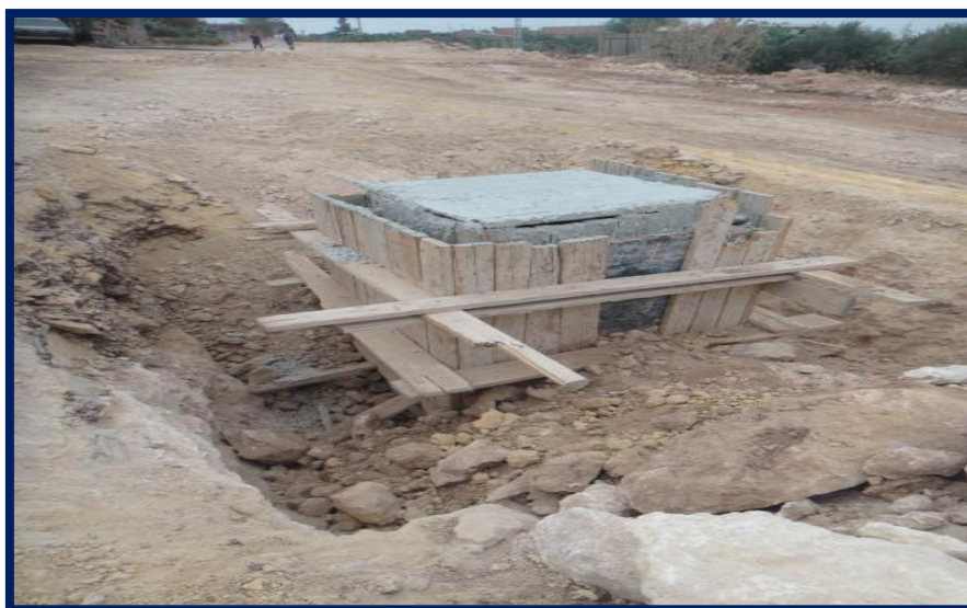
Figure VIII-2: Réalisation d'un regard.
