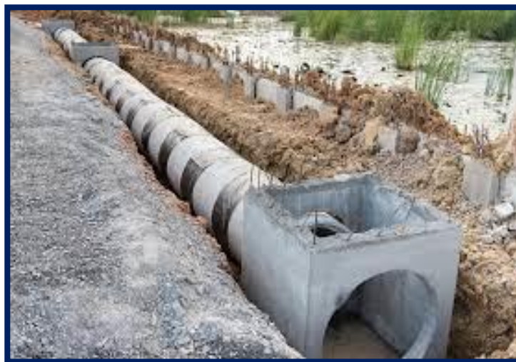
Figure VIII-5: Assemblage des conduites. Source : Google.
