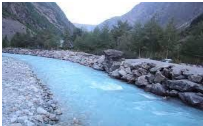
Figure V.4 : Aménagement des cours d'eau en enrochement.
