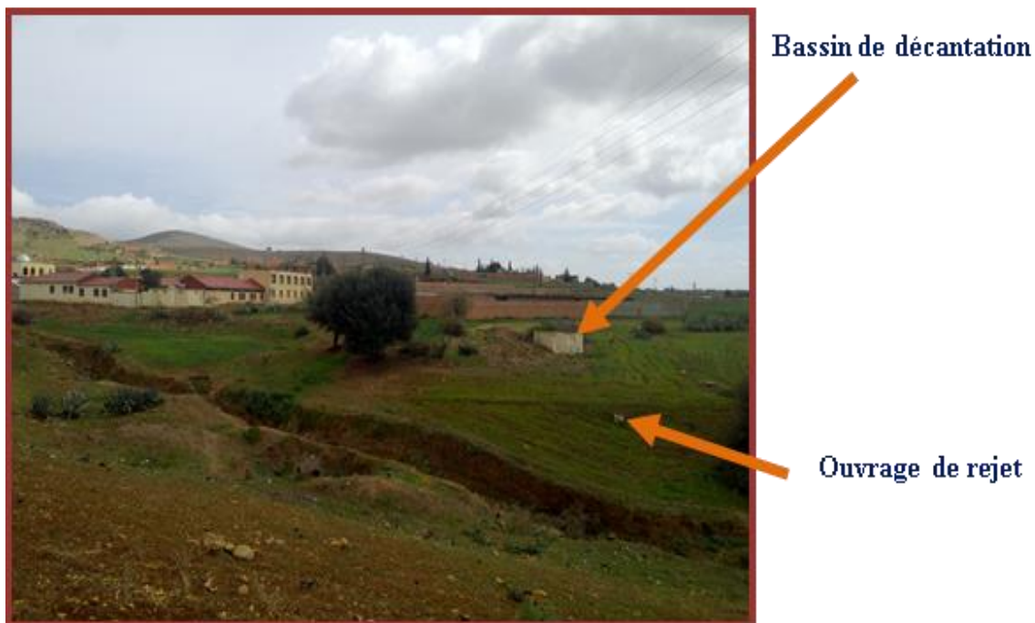
Figure VI-6: Bassin de décantation (fraction Ouled Ziri)
