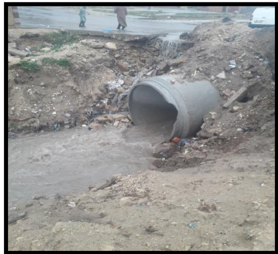
Figure III -3 : Sondage Galerie existante de section= b*h=2*1.80 (Etat dégradé)
