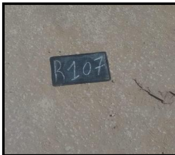
Figure III -7 : regard n°107 avec tampon en B.C
