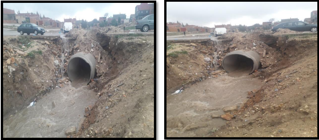
Figure III -4 : Traversée de la route (galerie dégradé remplacé par buse en béton armé DN1200mm) (Source : DRE)
