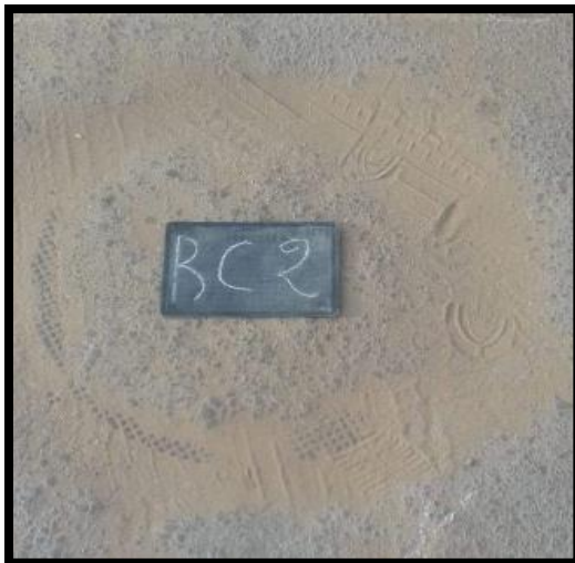
Figure III -6 : regard RC2 avec tampon Godronnée
