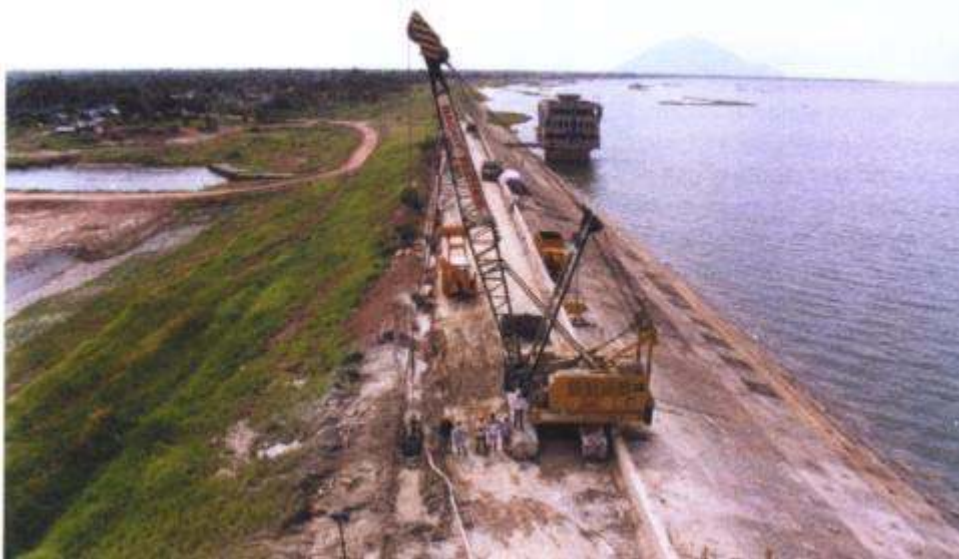
Fig.N° 41: Barrage de Dau Tieng - Vietnam - 1982 - Excavation de la paroi au coulis
