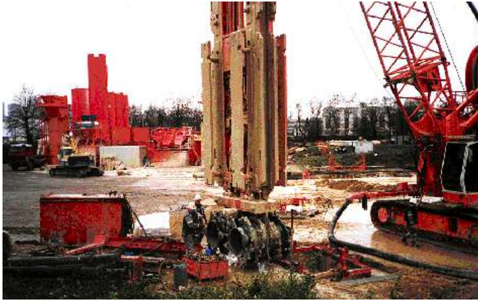
Fig.N° 34 : Hydrofraise : excavation d'un panneau
