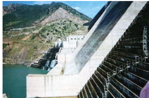
Fig. N3: Rive droite du barrage de Beni Haroun
