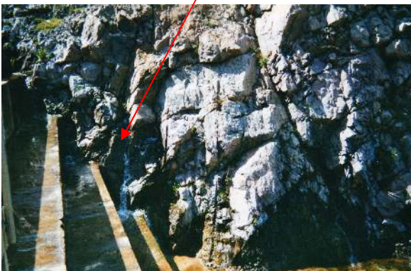
Fig. N°5: Infiltrations dans la rive gauche après les travaux du drainage et d'injection
