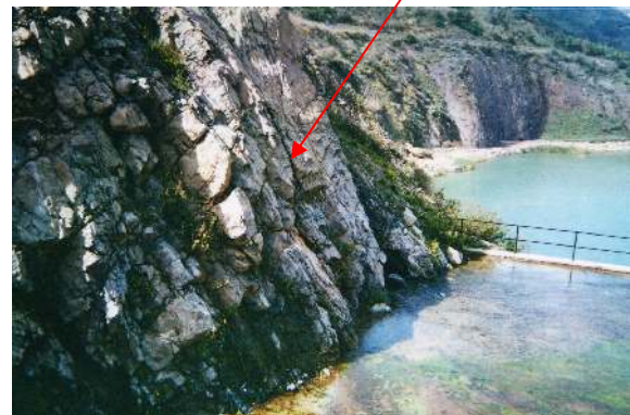
Fig. N°5: Infiltrations dans la rive gauche après les travaux du drainage et d'injection
