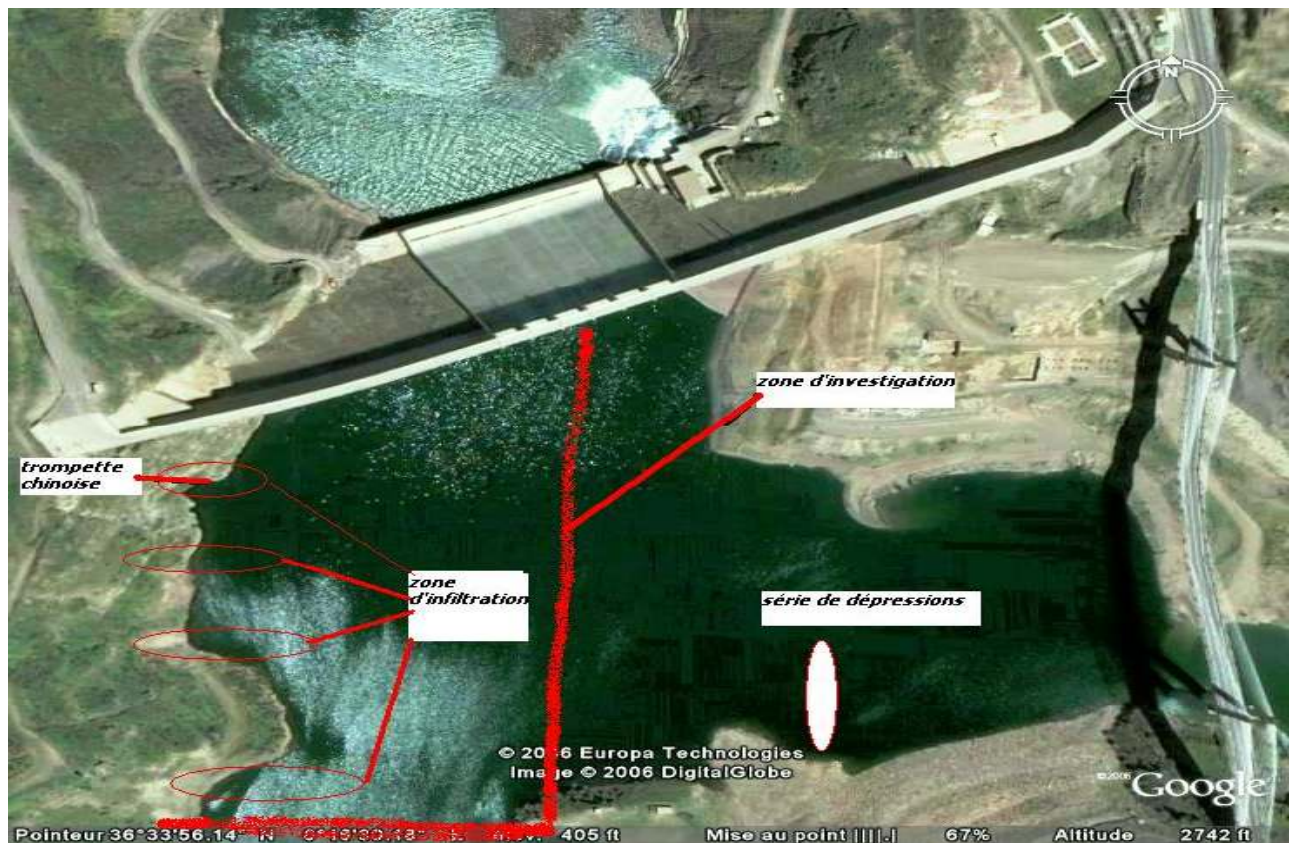
Fig. N° 8: les investigations de l'entreprise FUGRO GEOID SAS
