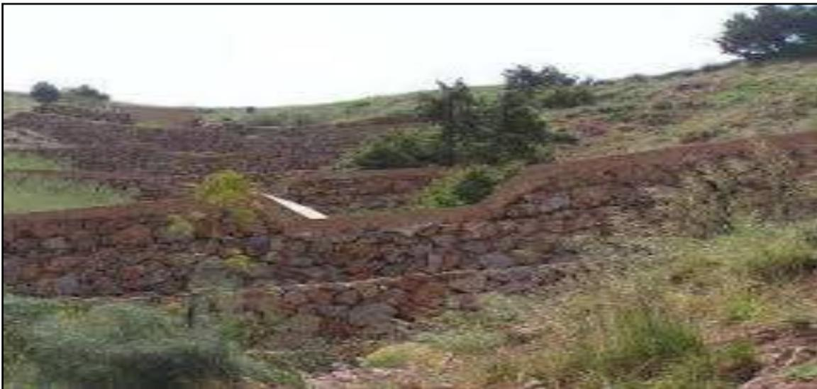
**Figure V.10.** Des seuils de correction torrentielle en gabion.
