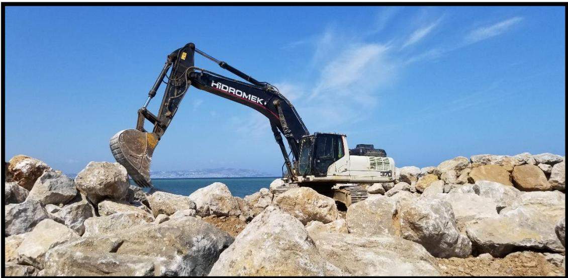
**Figure Annexe.7-** Mise en place des enrochements
