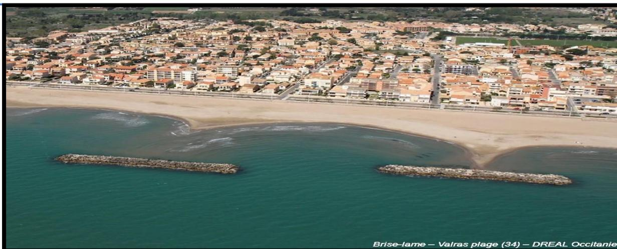
Figure I.7 – Exemple d'un brise-lame en enrochement (Valras plage, Occitanie, France)
