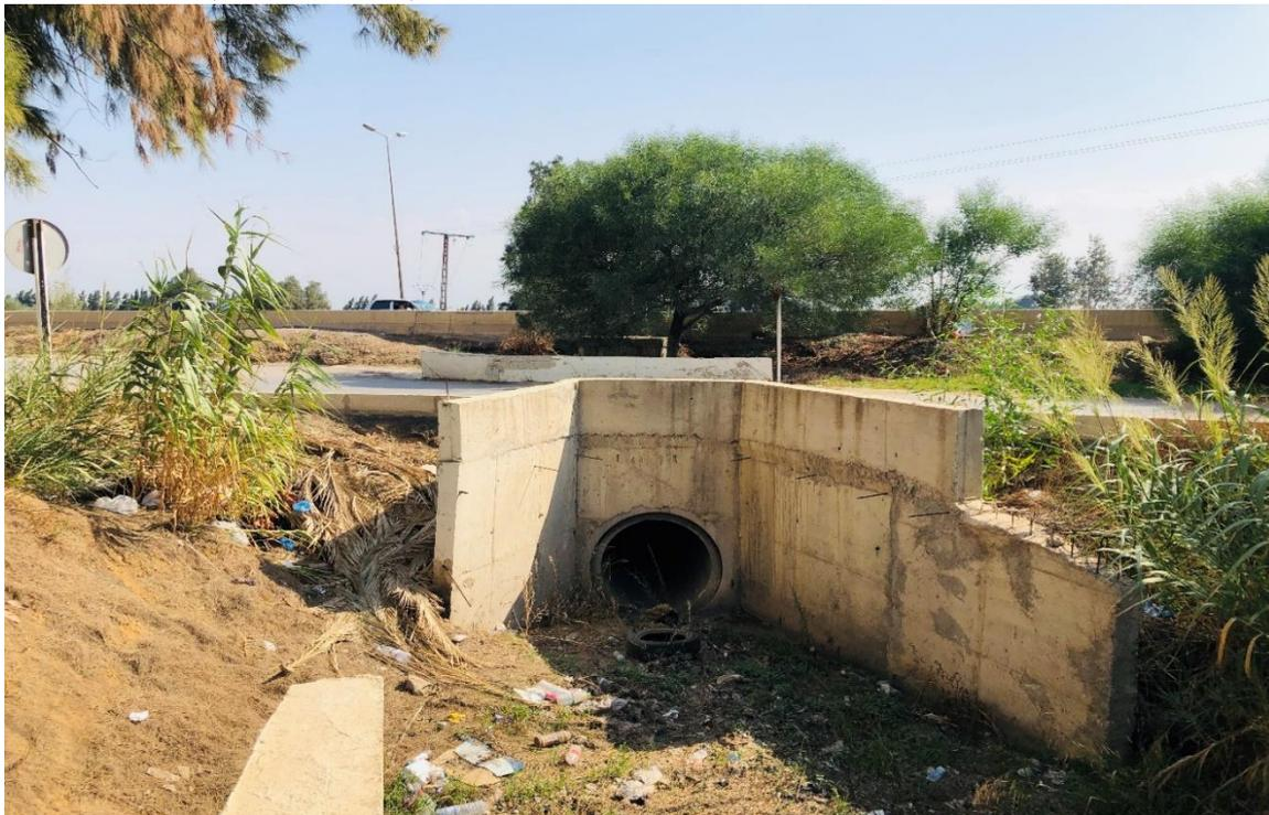
*Figure I:5 Début de la canalisation par une conduite de  $\varnothing$ 1000 – aout 2020*
