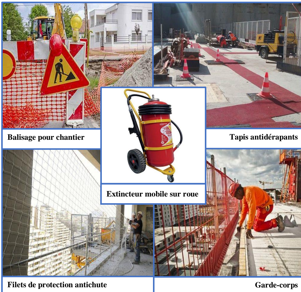
Figure VII. 1 : Équipements de protection collective à avoir sur un chantier
