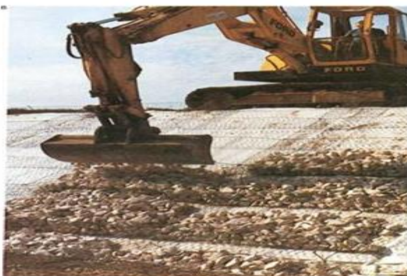
Figure VII. 2 : Remplissage de matelas reno. (Trad et Boulakhoua, 2015)
