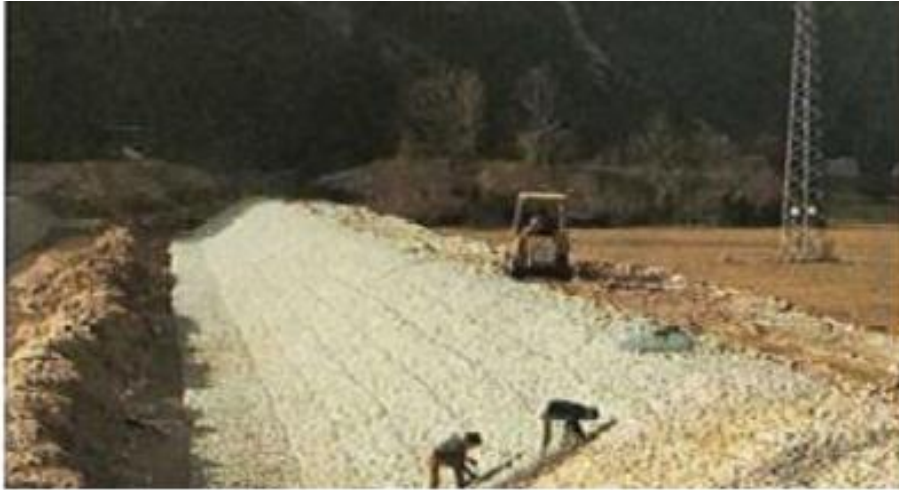
Figure VII. 3 : Fermeture du matelas Reno. (Trad et Boulakhoua, 2015)
