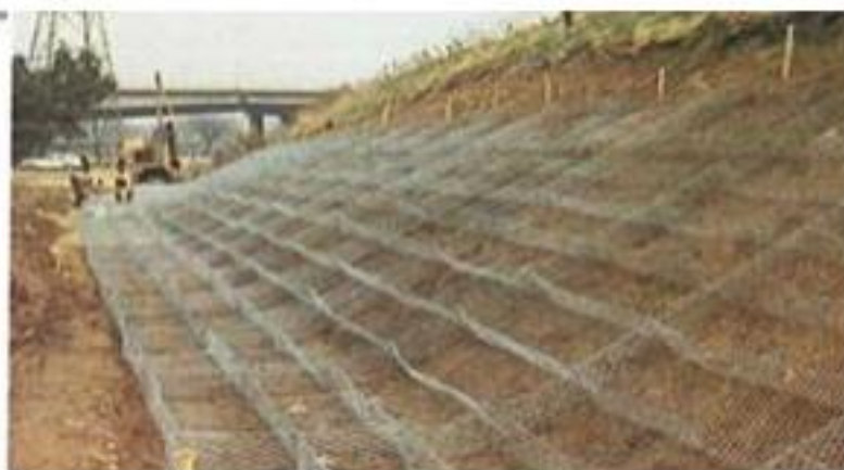
Figure VII. 1 : Préparation du font de matelas reno. (Trad et Boulakhoua, 2015)
