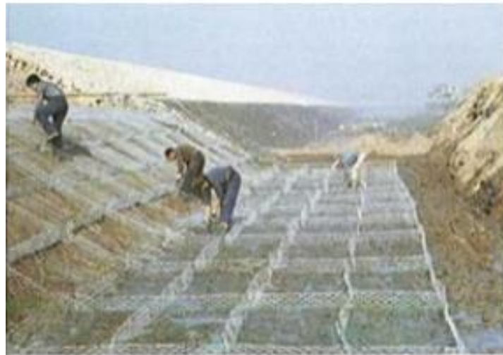
Figure VI. 6: Revêtements continus d'épaisseur modeste et de flexibilité considérable.
