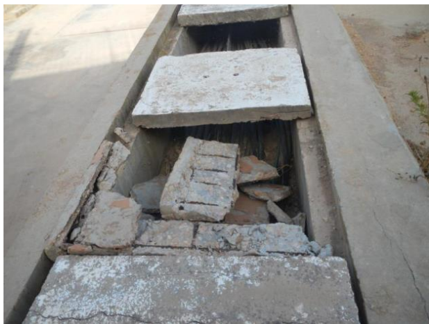
Figure III.8: Détérioration des dalles rive droite Figure III.9: Dalle de la cuve endommagée
