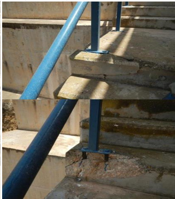
Figure III.15: Escalier menant à la galerie (rive droite)
