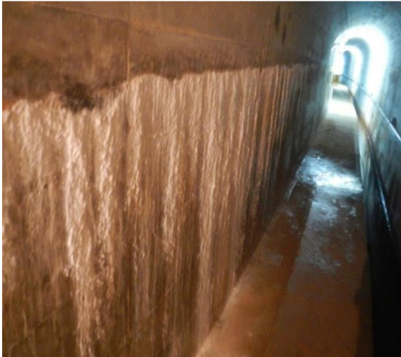
Figure III.20: Coulée de calcite humide(G2) Figure III.21: Matériau trouvé dans les galeries
