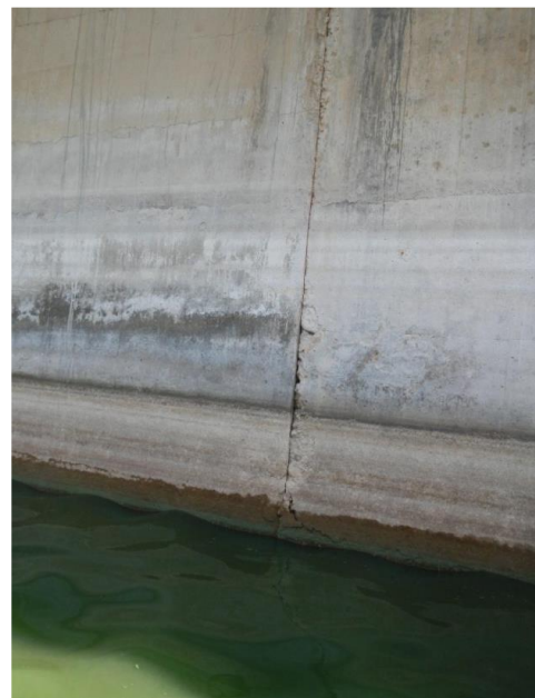
Figure III.3: Reprise par du mortier rive gauche Figure III.4: Joint légèrement altéré rive droite
