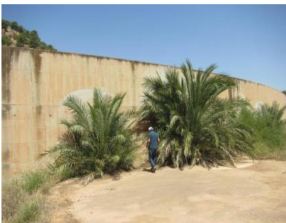
Figure III.33: Végétation proche des murs (rive droite)
