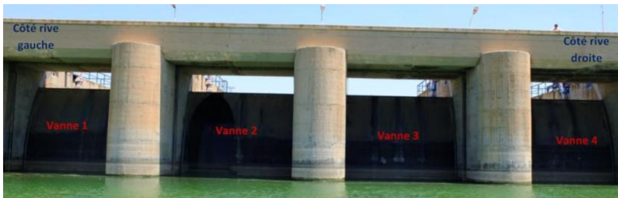
Figure I.10 : Evacuateur de crue (vue depuis l'amont)
