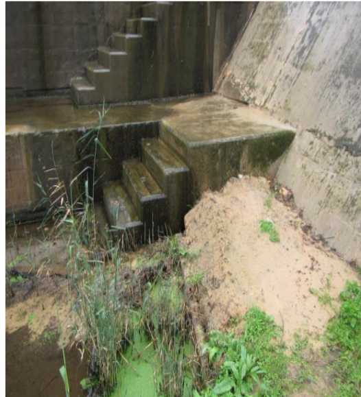
Figure III.17: Obturation du caniveau de pied parement rive droite
