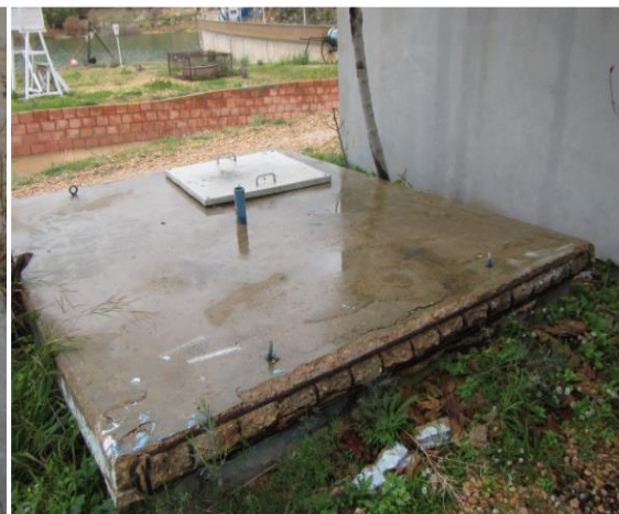
Figure III.8: Détérioration des dalles rive droite Figure III.9: Dalle de la cuve endommagée
