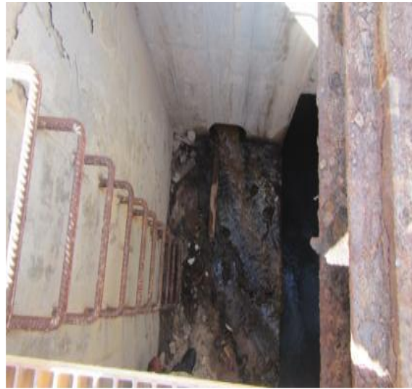
Figure III.38: Sortie des débits des drains dans la galerie de vidange.
