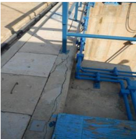
Figure III.5: Fissures en bordure de crête
