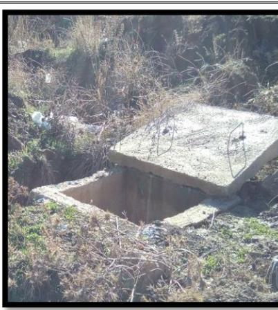
**figure II-2:** regard 2 avec dalle en béton armé
