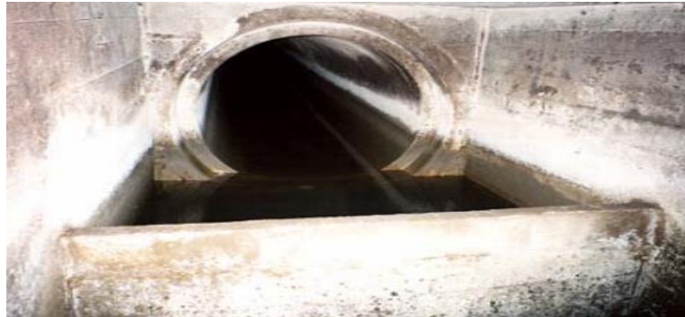
Figure VI-7 : Exemples de déversoir frontal
