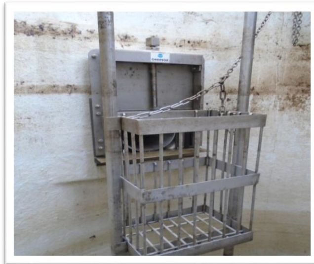
Figure VI-14 : Panier dégrilleur
