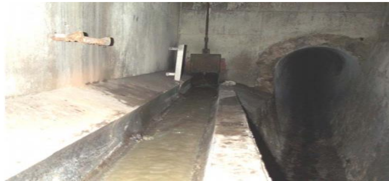
Figure VI-8 : Exemple de déversoir à seuil latéral
