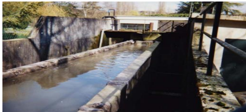
Figure VI-9 : Exemple de déversoir à double seuil.
