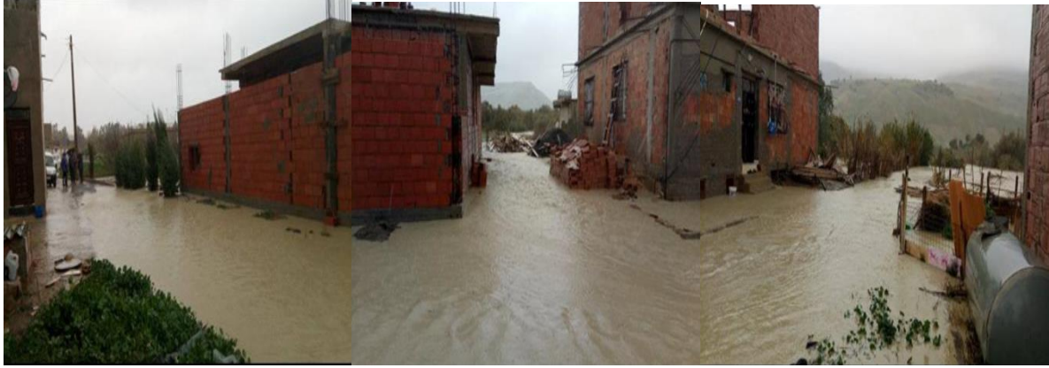
Figure n° I 12 Photos d'inondation causée par le débordement d'Oued Harbil (fraction Zamoura)
