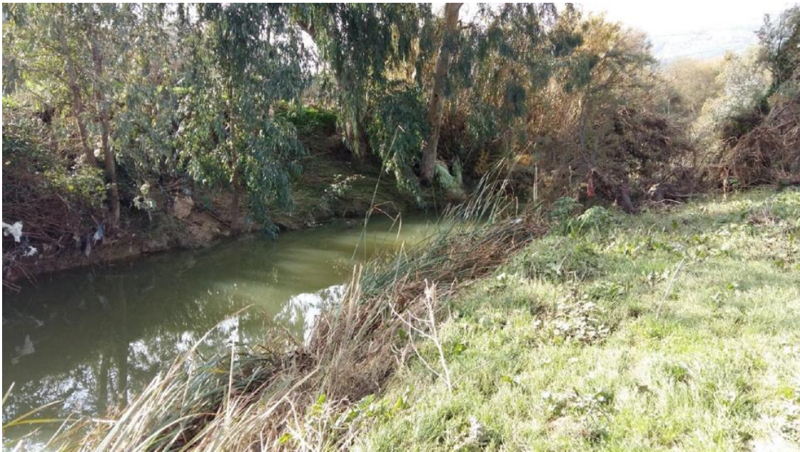
Figure n° I 14 Un rétrécissement du cours d'eau et le niveau de lit mineur élevé dans ce cas lors des crues un débordement de l'oued est facile
