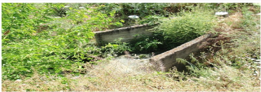
Figure V-14: Ouvrage rejet (à ciel ouvert).2015
