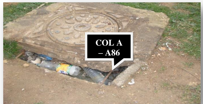
Figure V-9: Regard de visite (colmaté).2015 Planche de réseau existant : Collecteur A-R86
