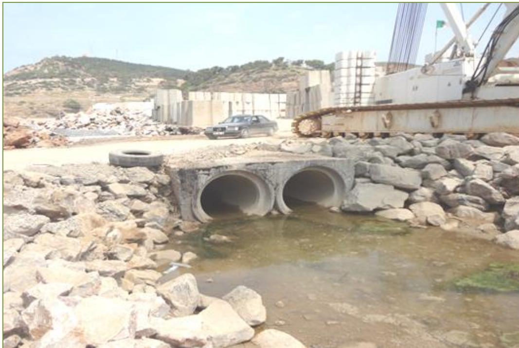
Figure IV.10 Traversée busé de l'Oued Menzal
