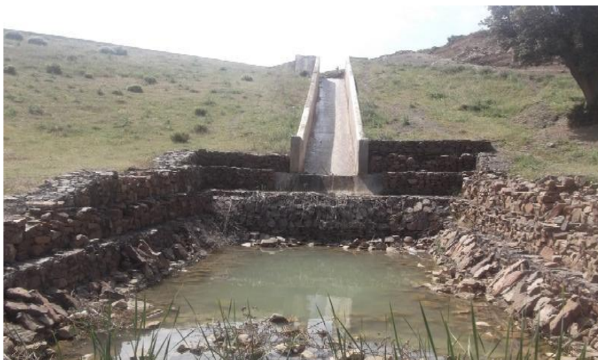
Figure N° II-2 : Vue de coursier et de bassin de dissipation de l'évacuateur de crue.
