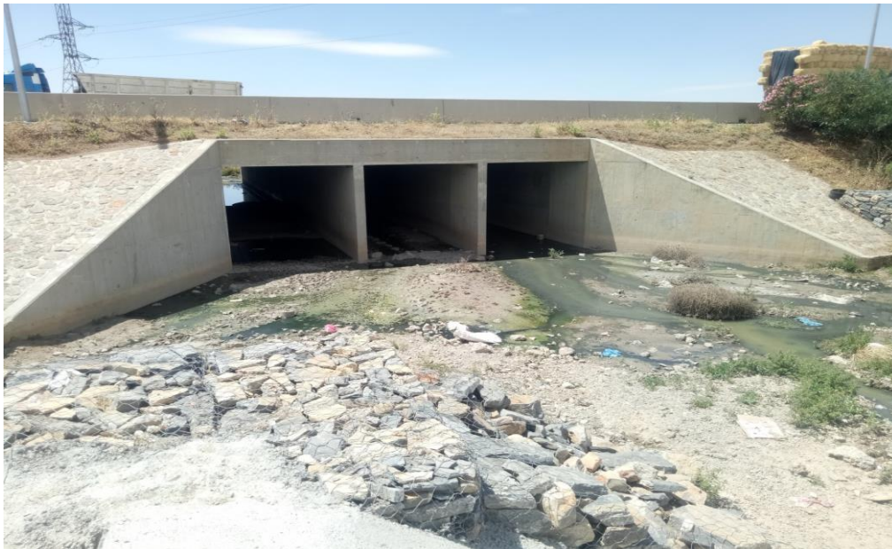
Figure IV.8. Pont sur l'autoroute Est-Ouest
