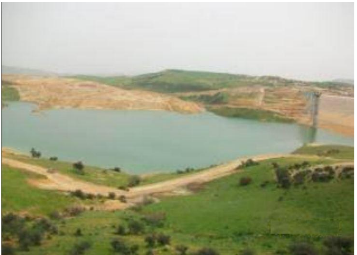
Figure III.1 : Barrage reservoirs du KERRADA
