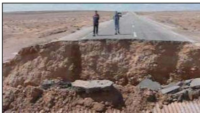
Figure 1.3 Chaussées détériorées lors de la crue du 01/10/2008 à Ghardaïa.
