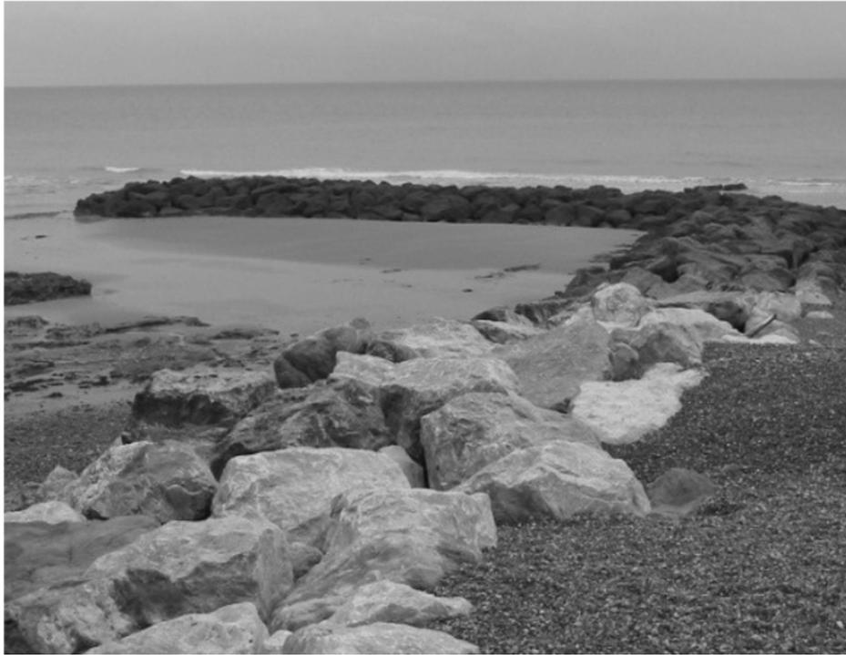
**FIGURE IV.3** – Épi en L, Bulverhythe, Royaume-Uni (source : Halcrow 2009 )
