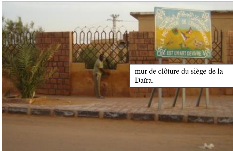
Figure II.4 : Trace laissée lors de la crue, mur de clôture du siège de la Daïra (In-AMINAS).
