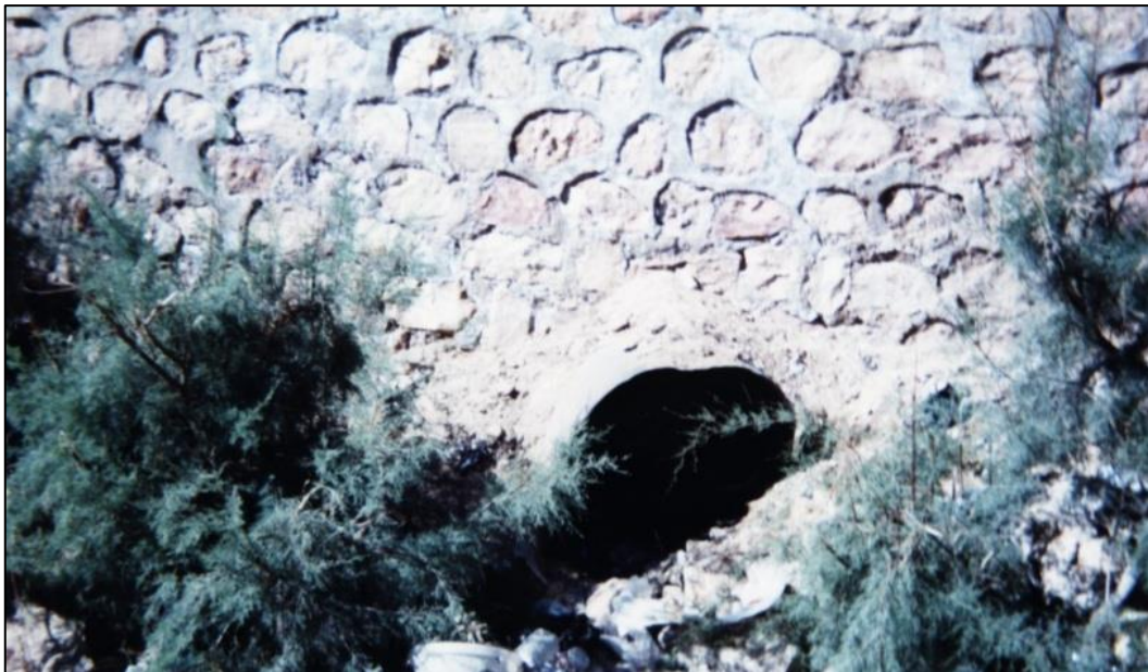
Figure VI.10 : Passage au-dessous de pont.
