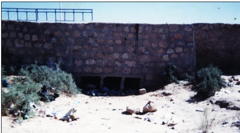
Figure VI.8 : Passage busé intégré au pont.
