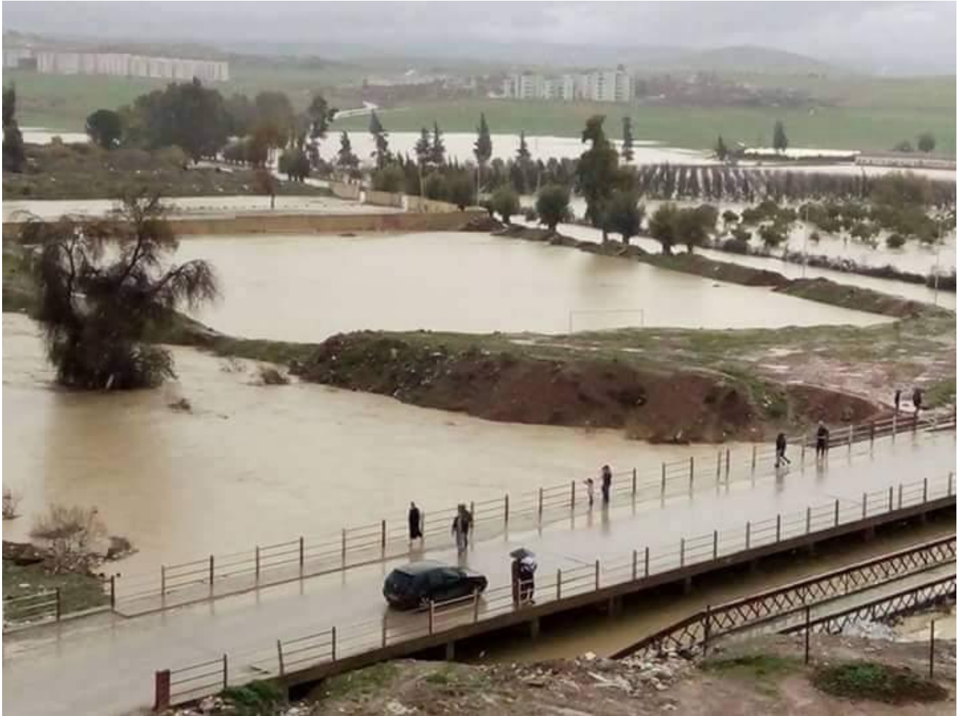
Figure IV-7: Inondations à Oued Fodda 2019 (pont Sidi Amar).
