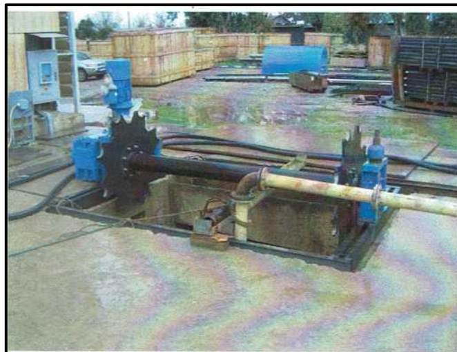
Figure 11 : Filtre à bande en cours de réhabilitation
