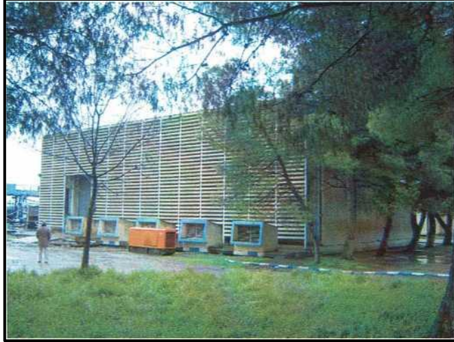
Figure 05 : SP Khemis II - Bâtiment
