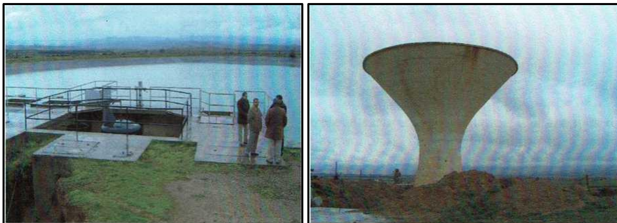
Figure 01,02 : SP Khemis II bassin au sol et réservoir surélevé
