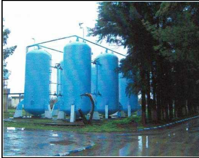
Figure 15 : SP Khemis II - Ensemble de ballons anti-bélier
