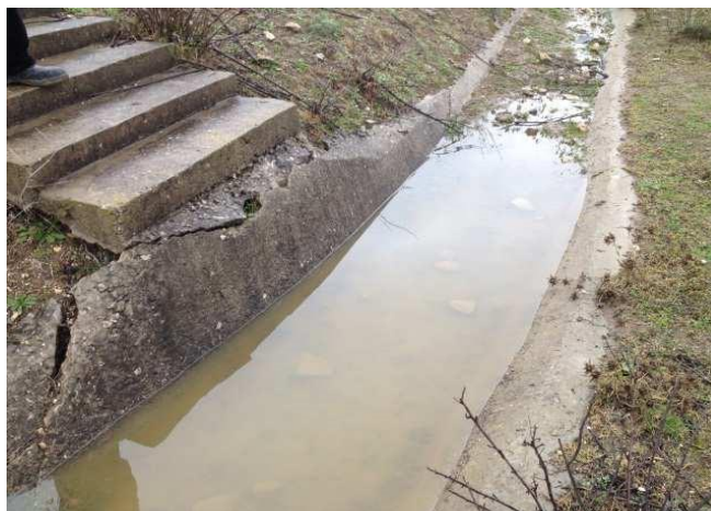
Figure II.7: Escaliers et caniveau talus aval (ISL, 2015)
