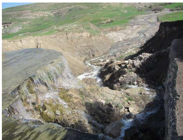
Figure II.16 : vu de l'amont (ISL, 2015)
