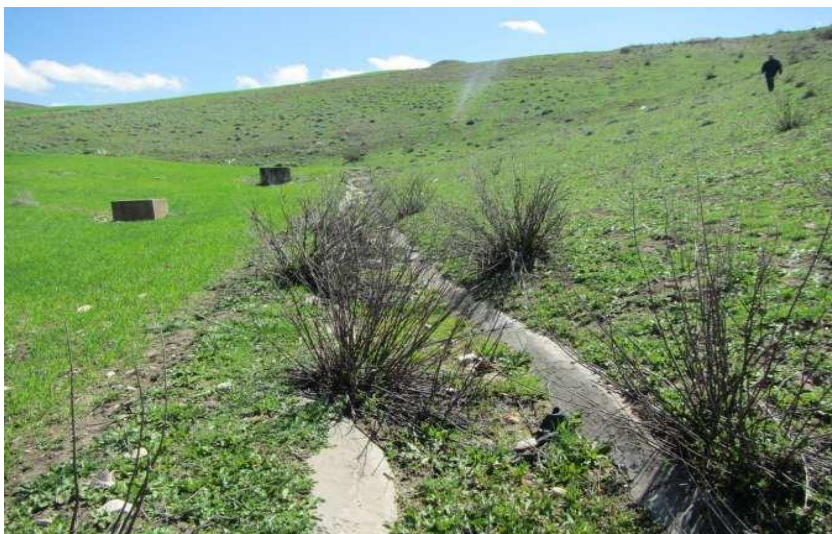
Figure II.31 : Puits de décharge pied aval (ISL, 2015)
