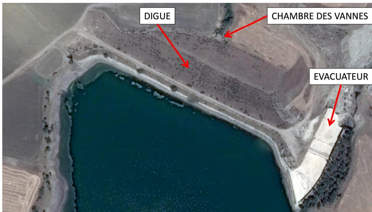
Figure I.14 : Vue aérienne de l'aménagement (ISL 2015)
