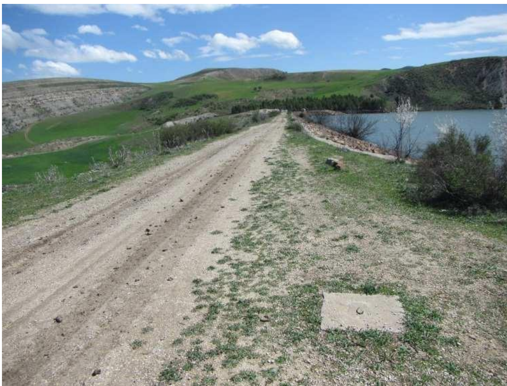
Figure II.3 : Crête du barrage vue de la RG(ISL, 2015)
