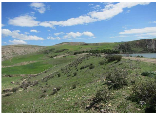
Figure II.5 : Parement aval du barrage (ISL, 2015)
