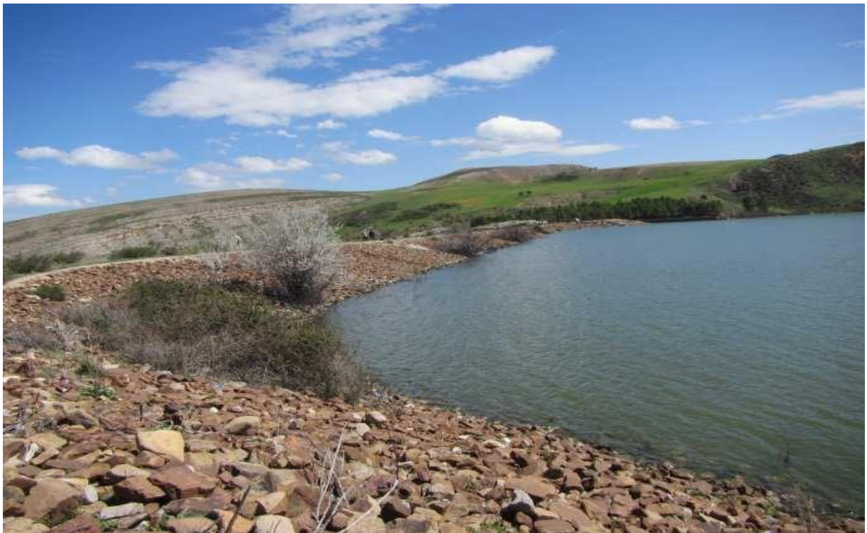
Figure II.1 : Parement amont rive gauche (ISL, 2015)
