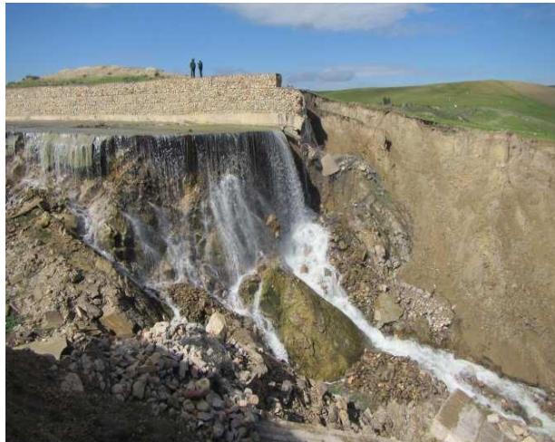
Figure II.14: Extrémité aval du coursier (ISL, 2015)
