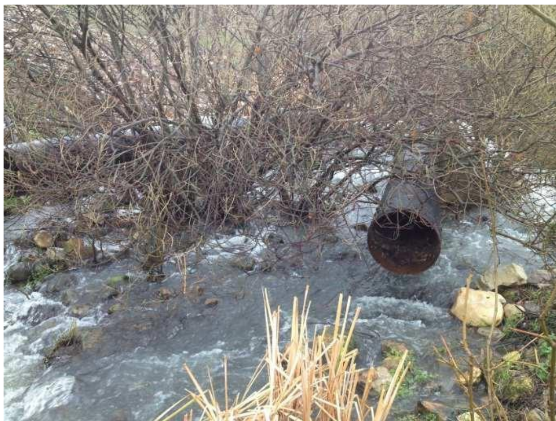
Figure II.28: Extrémité conduite prise d'eau(ISL, 2015)
