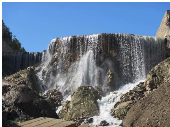
Figure II.15 : Chenal évacuateur de crues vu de l'aval (ISL, 2015)
