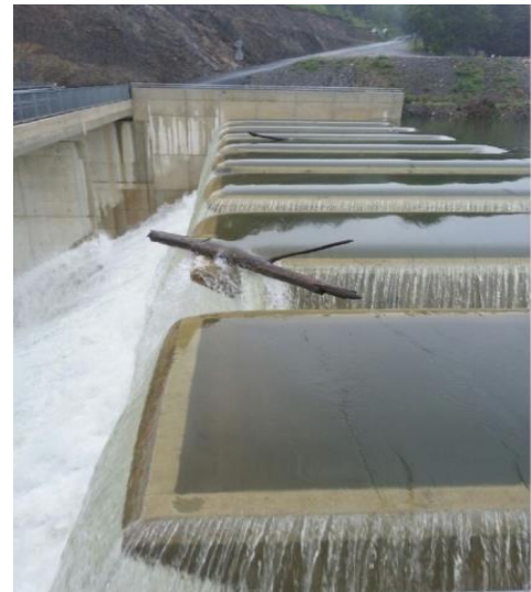
PK Weir déversant : barrage de Rassisse, France
