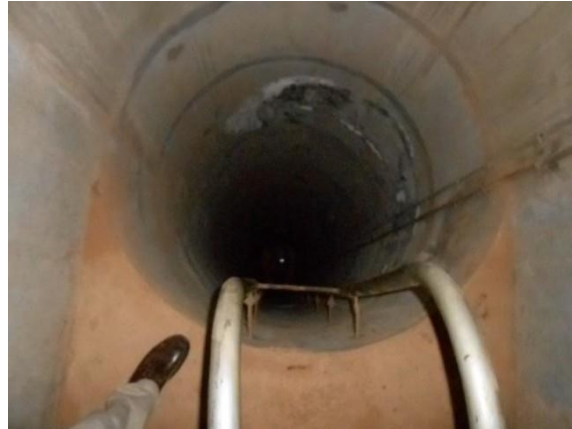
Figure II.22 : Puit de descente à la galerie.
