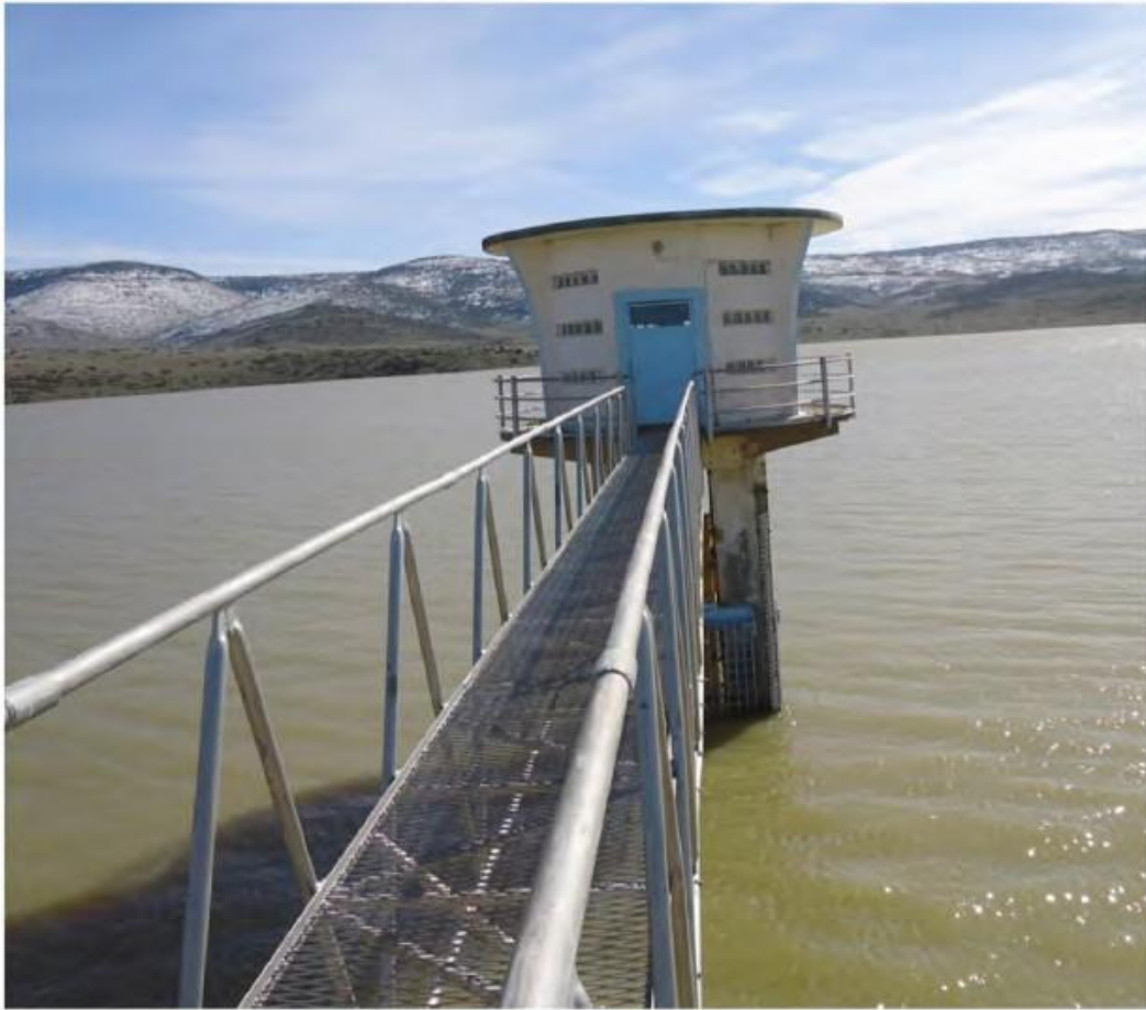
Figure I.5 : Photo de la prise d'eau
