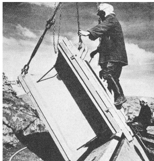
Figure III.34 : Calage d'un voussoir.
