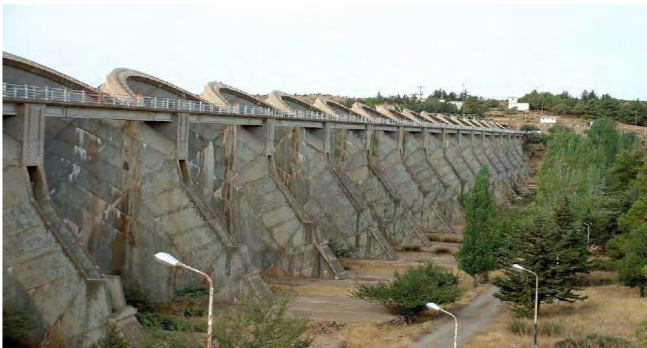
Figure I.3 : photo des évacuateurs de crues du barrage Meffrouh.
