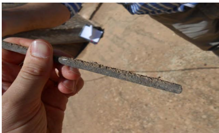
Figure II.20 : Vue en détails d'un câble de précontrainte.
