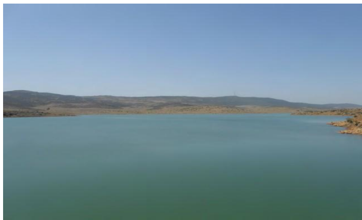
Figure II.11 : Vue du réservoir depuis le barrage.
