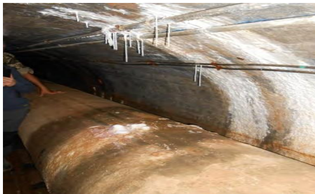
Figure II.25 : Conduite dans la galerie d'amenée.
