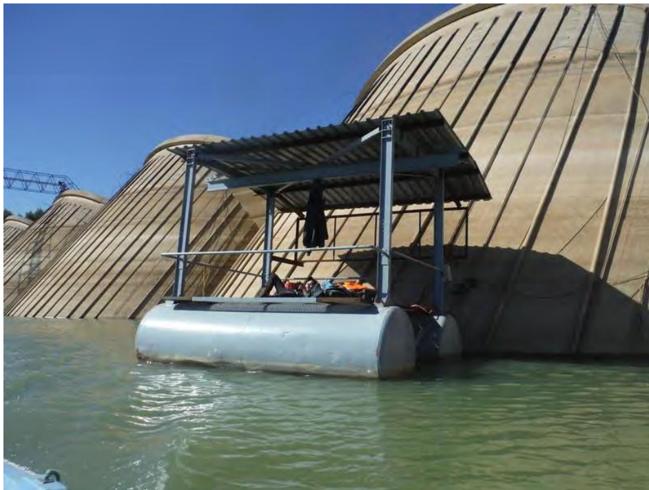
Figure III.48 : Plateforme de travail.
