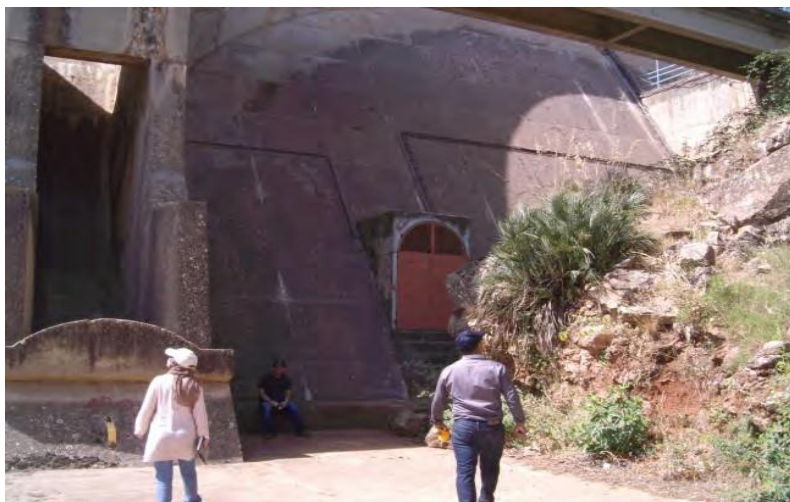
Figure II.3 : Affleurement rocheux sur la rive gauche et entrée à la galerie au pied du barrage.
