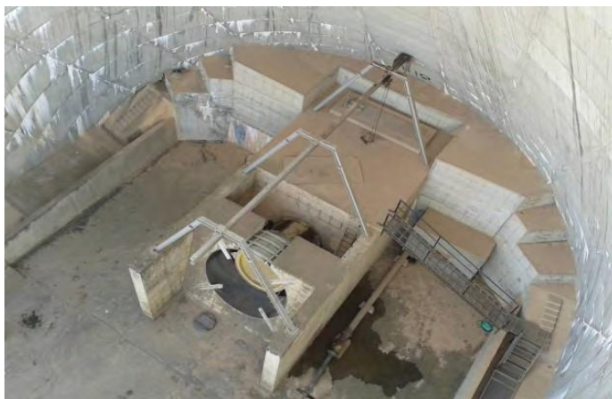
Figure II.32 : Vue générale de la vidange de fond.
