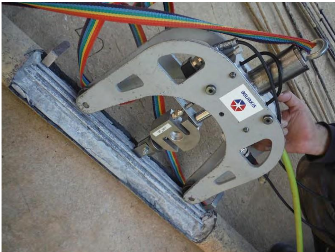
Figure III.43 : Vue du dispositif de mesure IN-TENSE
