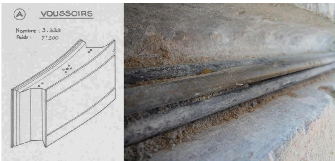
Figure III.37 : Vue sur la précontrainte annulaire après démolition du mortier
