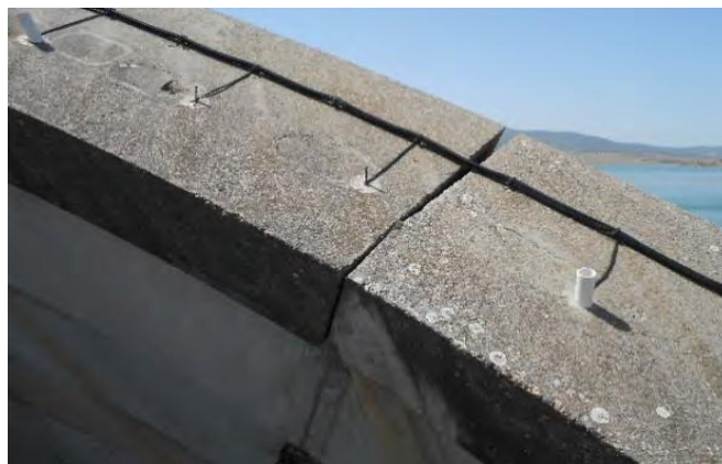
Figure II.29 : Ouverture des blocs supérieur des voutes.
