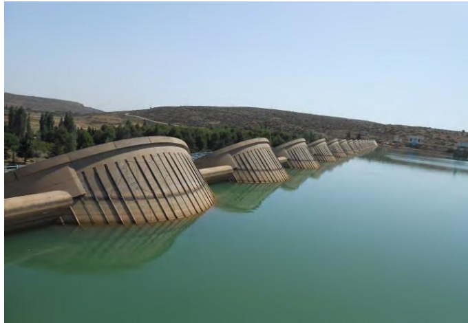
Figure II.9 : Partie visible du parement amont.
