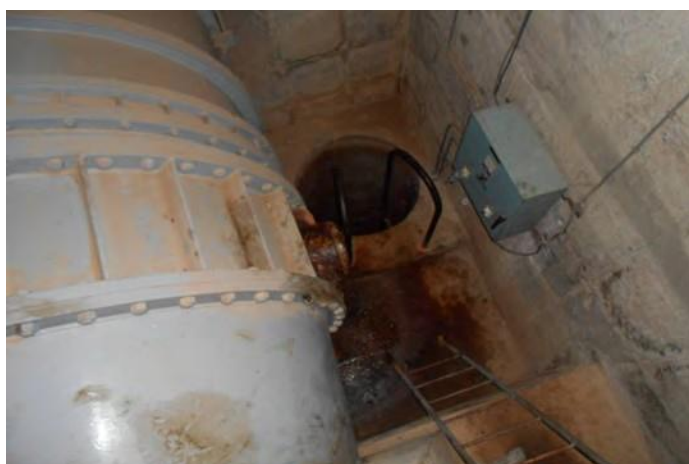
Figure II.33 : Détails de la valve papillon de sécurité et son tableau de contrôle.
