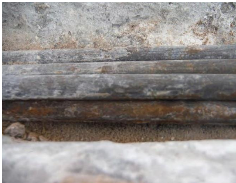
Figure III.60 : Voûte 10-11 – FP2 – Fils légèrement enrouillés.
