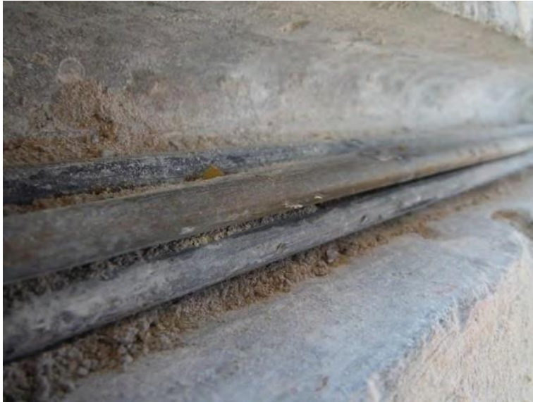
Figure III.59 : Voûte 3-4 – FP1 – Fils en bon état de conservation.
