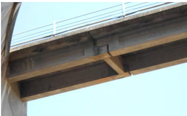
Figure II.12 : Joints de connexion de la de la passerelle.
