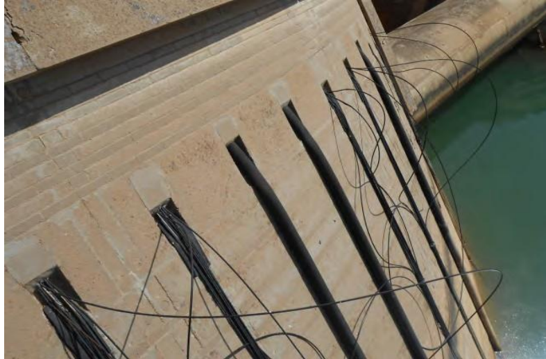
Figure II.18 : Câbles de précontraintes.
