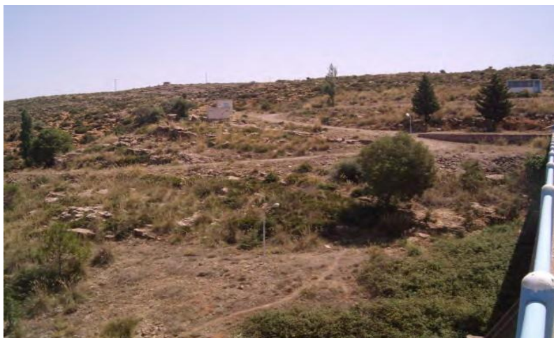
Figure II.6 : vue de rive droite, pendage des dolomies calcaires d'environ 10-15° vers l'amont.
