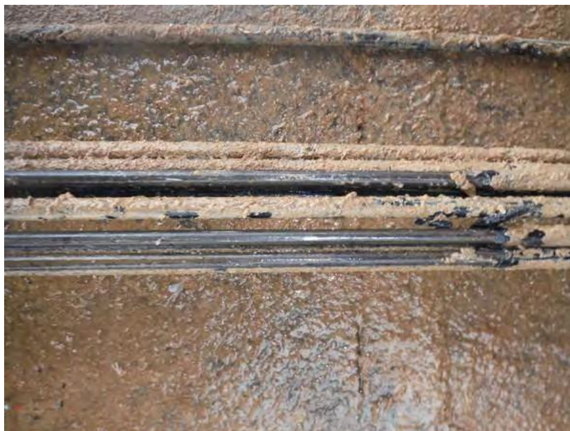
Figure III.55 : Voûte 3-4 – Câble 19 Fils en bon état de conservation.
