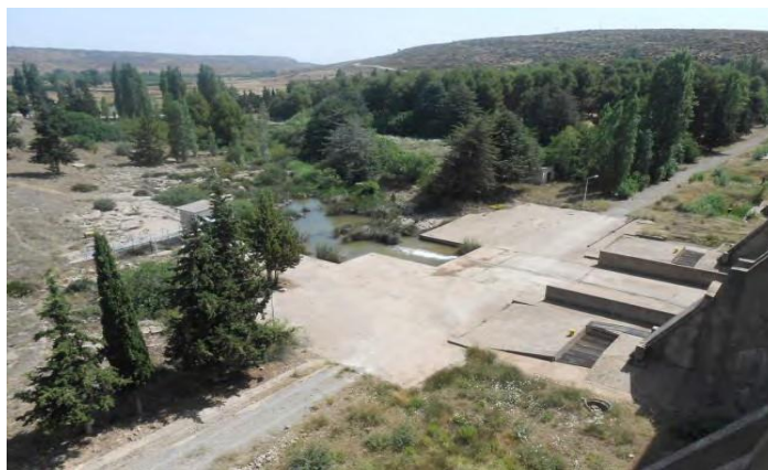
Figure II.10 : Vue du pied aval du barrage.
