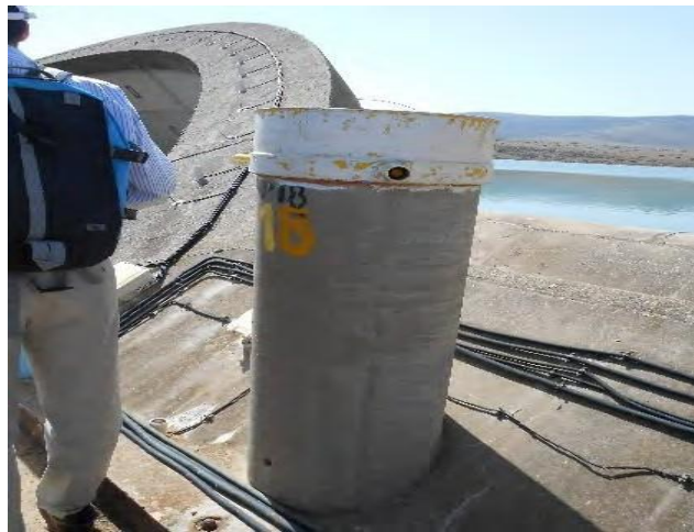
Figure II.27 : Pilier topographique sur la crête du barrage.
