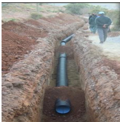
Figure VII.2. pose de canalisation.
