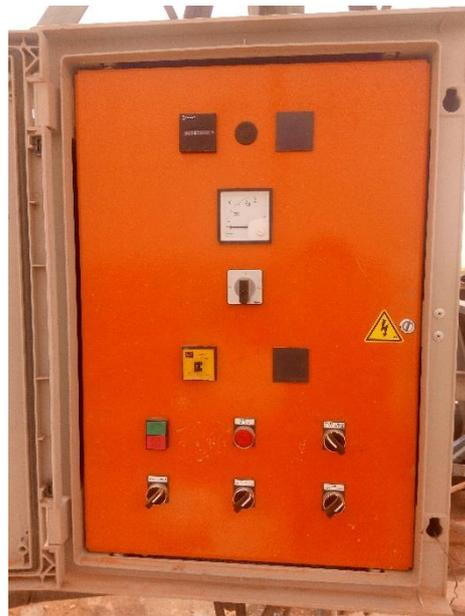
Fig IV-9 : Schéma d'armoire de commande du pivot
