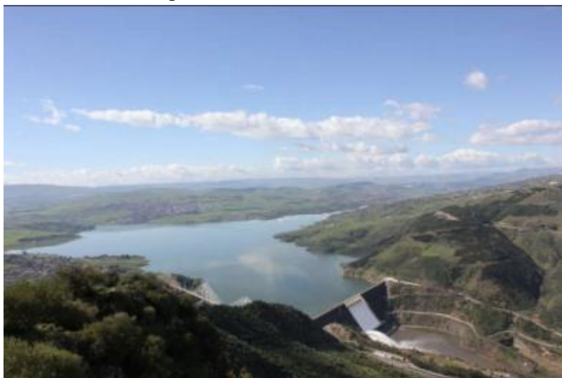
Figure II. 2. Photo du barrage de Beni Haroun après la mise en eau (A.N.B.T, 2014)
