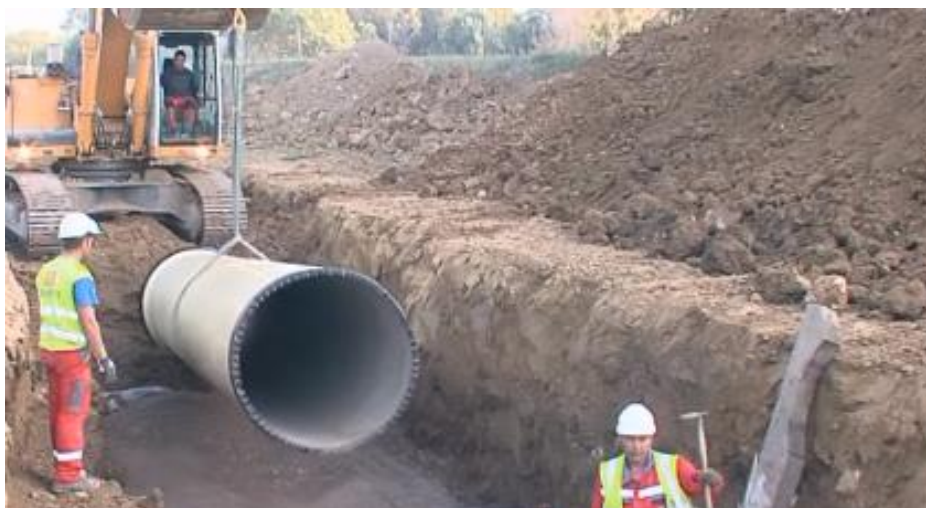
Figure 3 : Mise en place des canalisations
