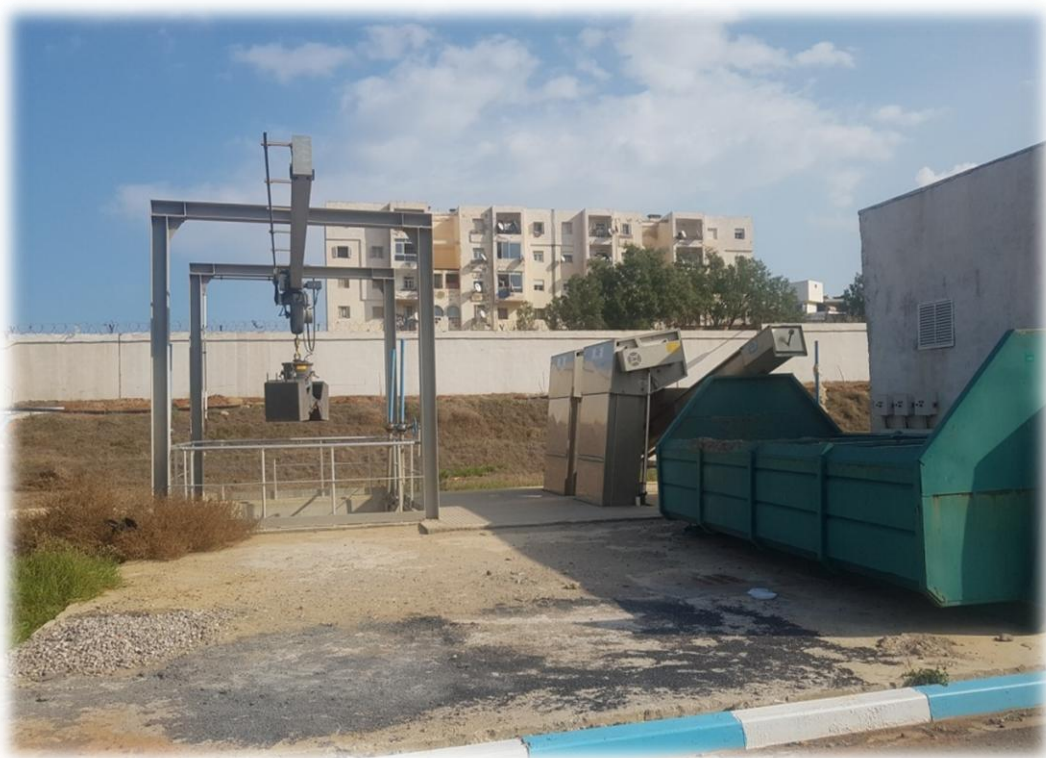
Figure III-1 : Photo illustrant la fosse à batard.
