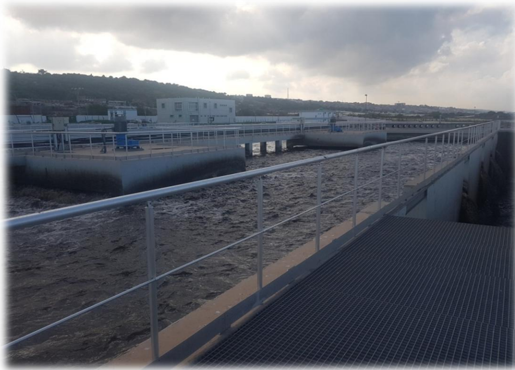
Figure III-4 : le bassin biologique avec la zone de dégazage.
