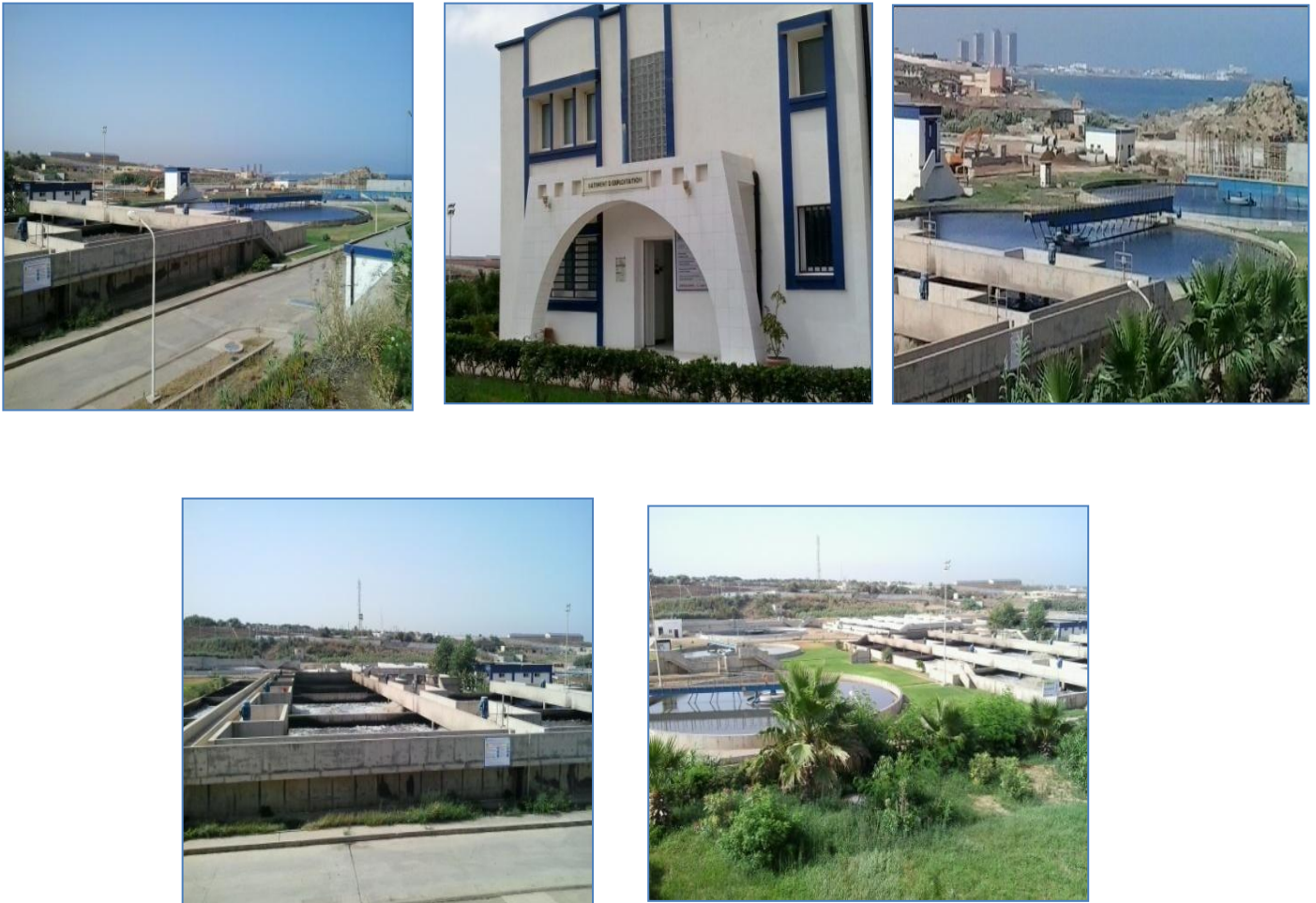
Figure III-1 : Les différents éléments de la STEP (source: Step Beni Messous)
