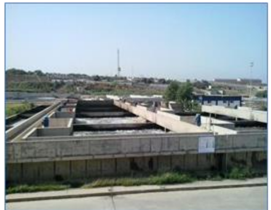
Figure III-6 : Bassin d'aération. (source: Step Beni Messous)
