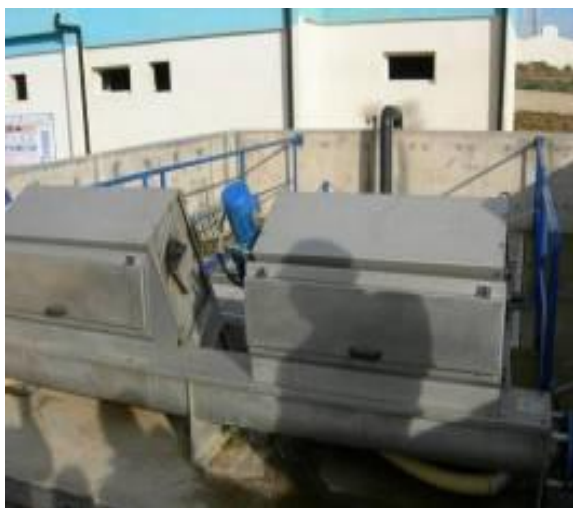
Figure III-3 : Le dégrillage.
