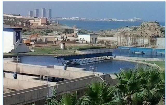
Figure III-7 : Les clarificateurs 1 et 2 (source : Step Beni Messous)
