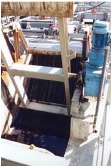
Figure II.2 Dégrilleur à grilles courbes
