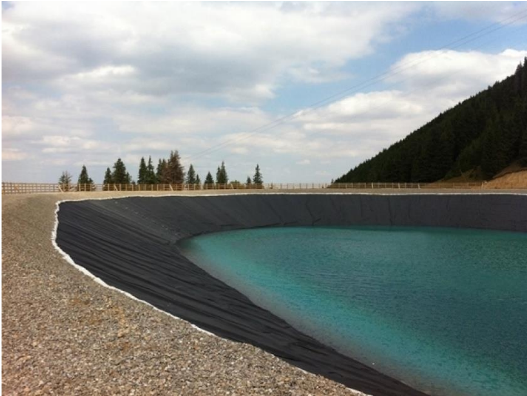
Figure 25 : Lagune étanchée par géomembrane
