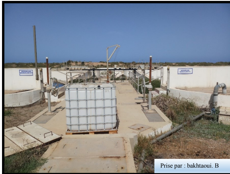
Figure III- 10 : Répartiteur Prétraitement
