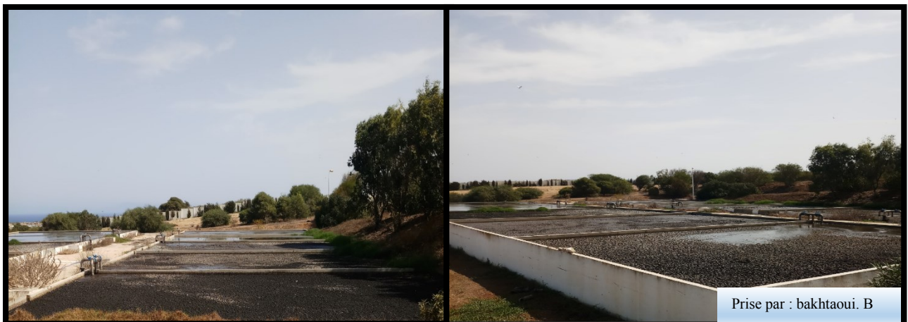
Figure III- 26 : Lits de séchage.
