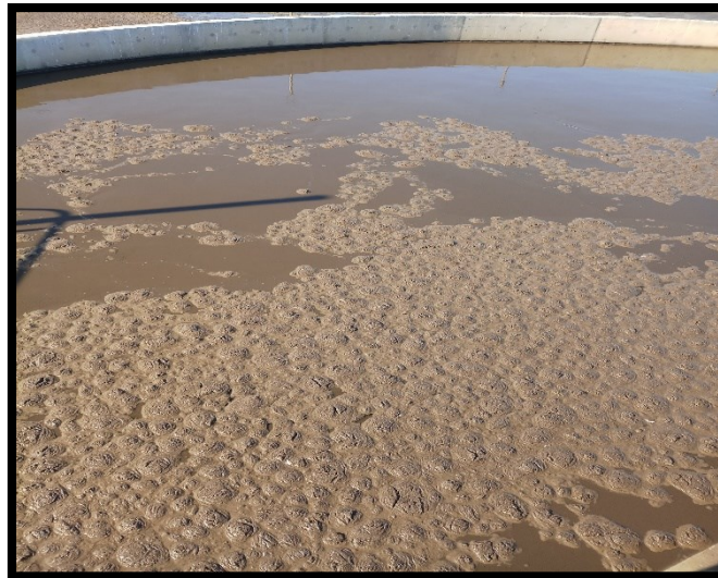
Figure V- 2 : Mousse biologique présente dans la STEP CAP FALCON.
