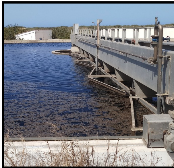
Figure V- 3 : Les Matières Flottantes instables présente dans la Step Cap Falcon.
