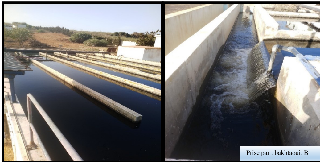
Figure III- 22 : Canal sortie file eau après chloration
