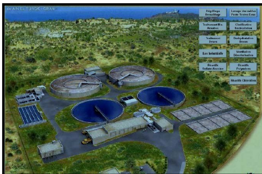
Figure III- 1 : Station d'épuration de Cap Falcon.
