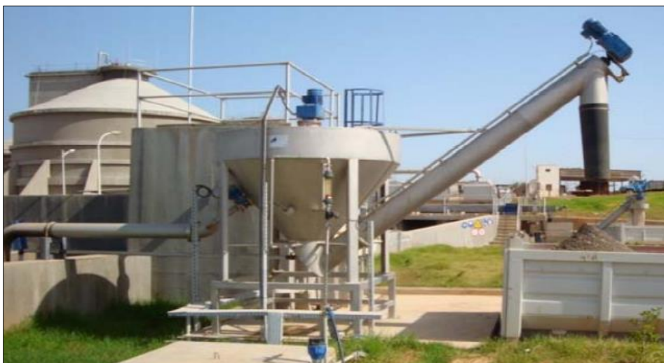
Figure 46 Classificateur et laveur de sables (STEP Elkarma)
