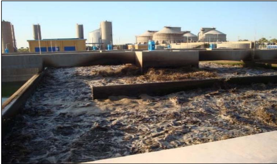
Figure 48 Bassin d'aération (STEP Elkarma)
