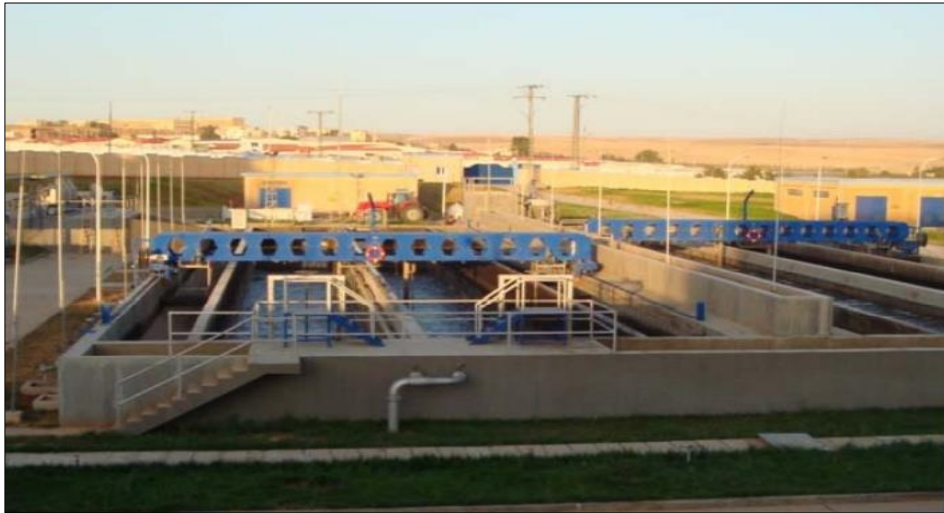
Figure 45 Dessablage- déshuilage (STEP Elkarma)
