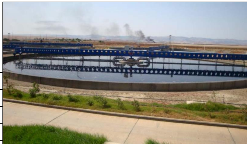
Figure 49 decanteur secondaire (STEP Elkarma)
