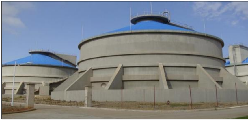
Figure 54 Digesteur anaérobie (STEP Elkarma)
