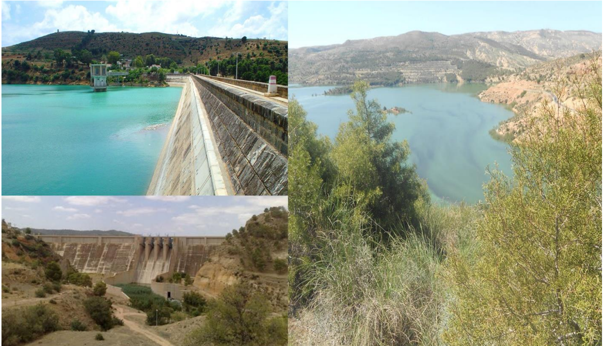
Figure III-2 : Vue générale de la cuvette du barrage de Tlélat, Source ONID – Groupement SCET-Tunisie / ENHYD
