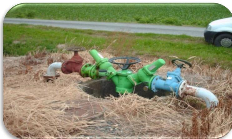
**Figure.VI.1 :** borne d'irrigation
