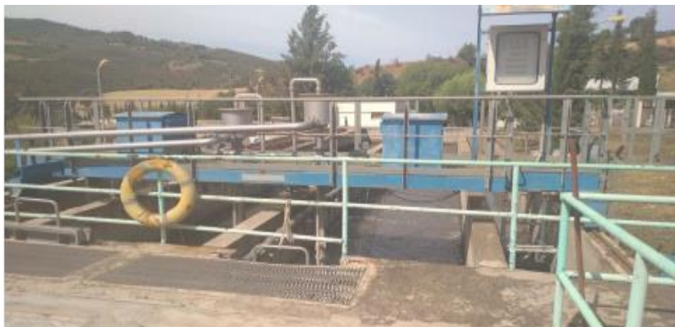
Figure II.4 : D essableur et d eshuileur de la STEP de M ed ea.
