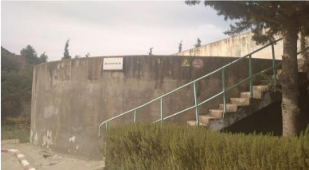
Figure II.8: épaisseur de la STEP de Médéa.
