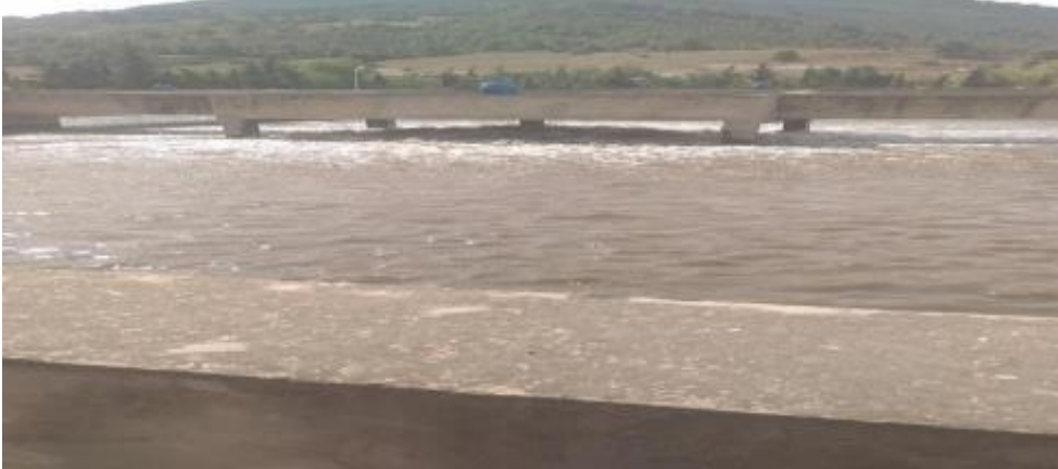
Figure II.5: Bassin d'aération de la STEP de Médéa.
