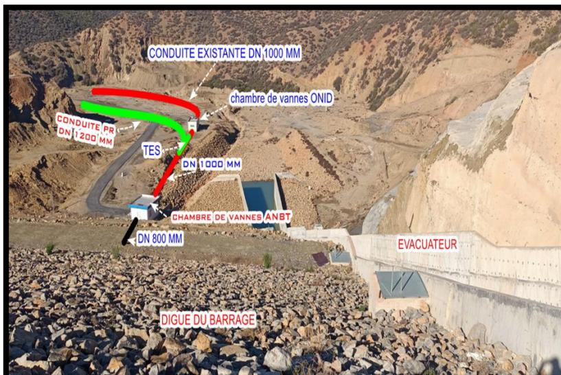
**Figure V.2:** Schéma d'adduction Barrage vers station de pompage
