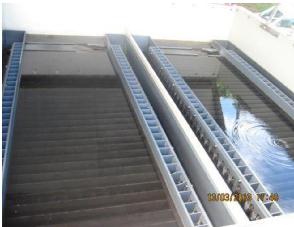
Figure I.5: Décanteur lamellaire. (Source : [ecolycee.e-monsite.com](http://ecolycee.e-monsite.com))
