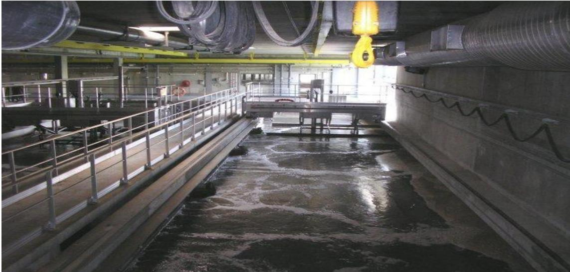
Figure I.3: Dessablage, déshuilage et dégraissage dans un seul ouvrage (Source : [www.u-picardie.fr](http://www.u-picardie.fr))
