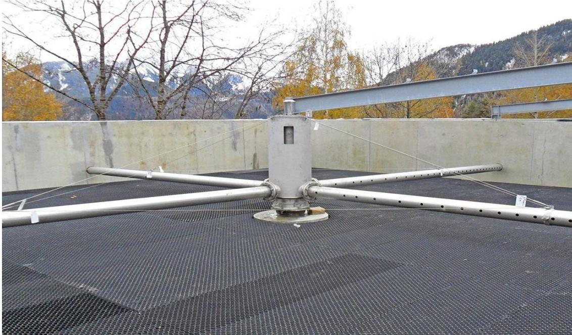
Figure I.10: lit bactérien avec sprinkler. (Source : [www.ricom-web.com](http://www.ricom-web.com))
