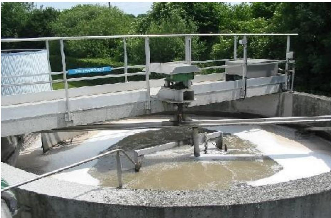
Figure I.4: Photo d'un racleur d'huiles et graisses ([www.u-picardie.fr](http://www.u-picardie.fr)).
