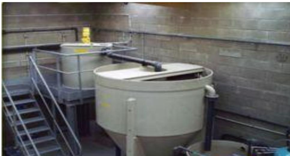
Figure I.6: Décanteur cylindro-conique. (source : [www.actibio.fr](http://www.actibio.fr))
