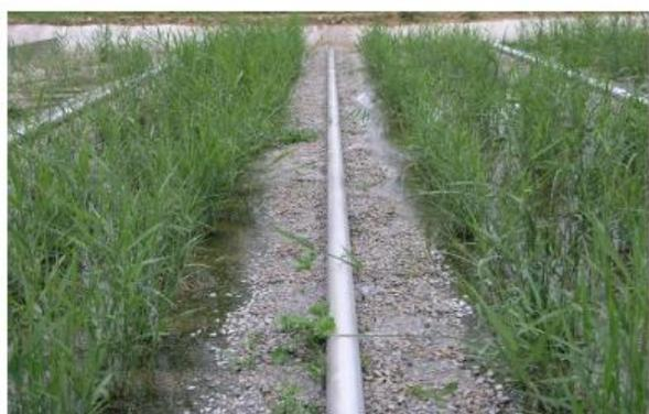
Figure III-11: rampe de distribution deuxième étage.
