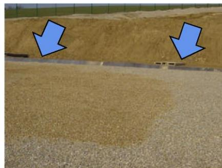
**Figure V-6 : Exemple d'un filtre non protégé risquant de collecter les ruissellements des abords.**
