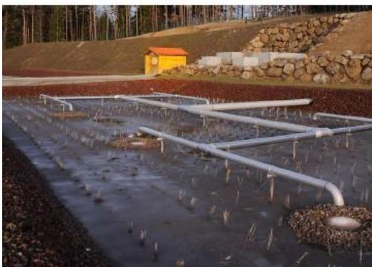
Figure III-9: rampe de distribution du premier étage.
