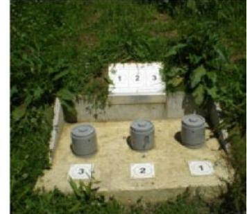
**Figure III-8: dispositif d'alternance (Vanne guillotine).**
