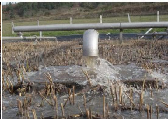
Figure III-10: système anti-affouillement.
