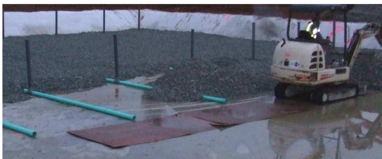
Figure V-8: Mini pelle sur chenille avec tapis de protection.
