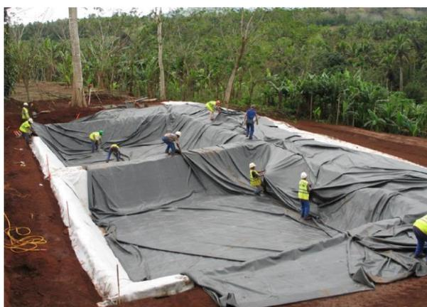
Figure V-2 : Exemple de mise en œuvre d'une étanchéité par géomembrane à Hachenoua.
