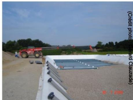
Figure V-7: Exemple de mise en place des granulats.
