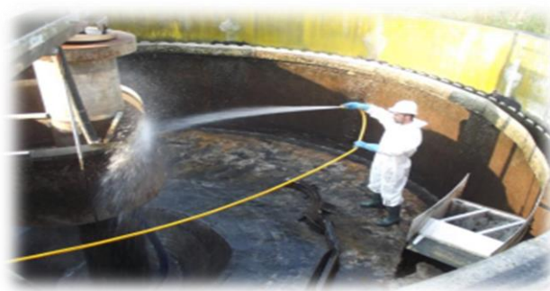
Figure VII.1 : L'entretien d'un bassin d'une STEP
