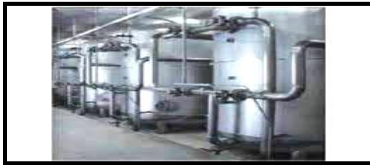
Figure II.13 : Filtre charbon actif
