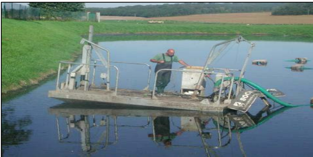
Figure XI : curage des boues à partir d'un radeau
