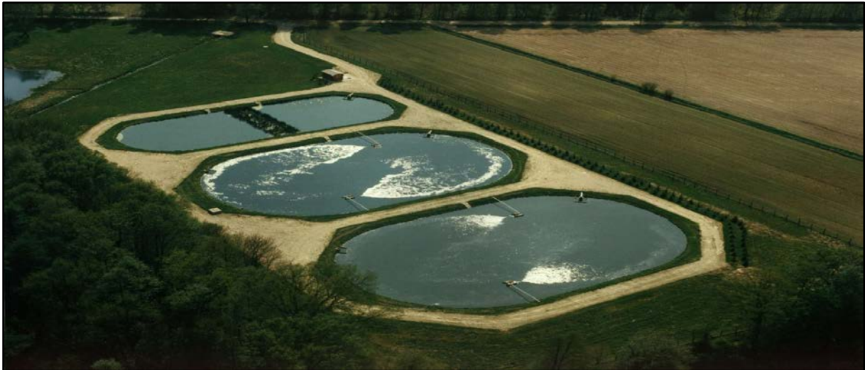
Figure II.3 : Système d'épuration par lagunes aérés.
