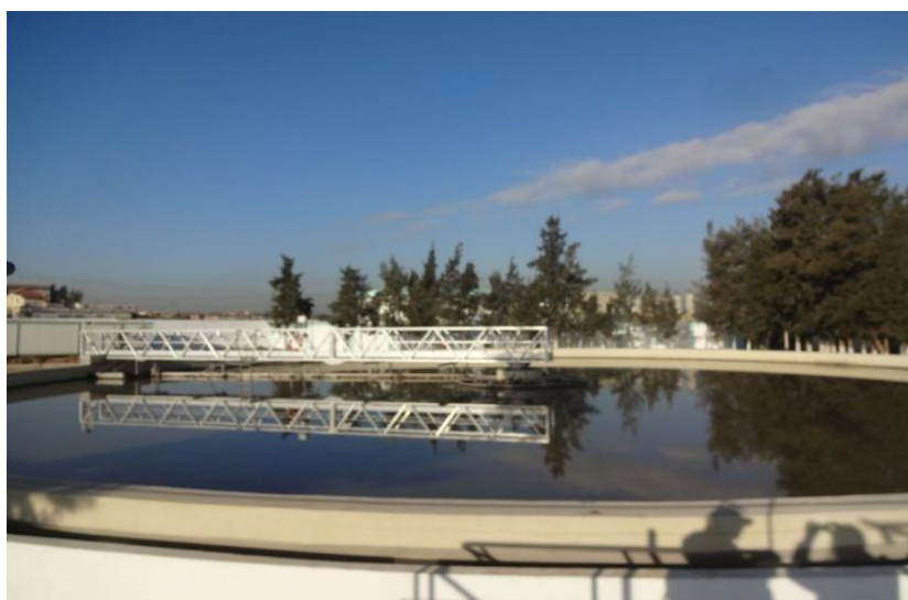
FIGURE 3.8 – Décanteur primaire de la STEP de Béni Mered
