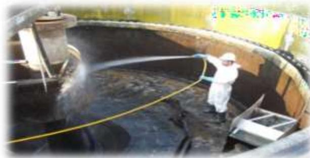
**Figure VII.1** : L'entretien d'un bassin d'une STEP
