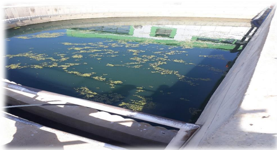
Figure_III_07 : Bassin d'épaississement.
