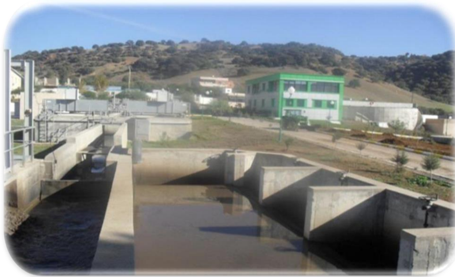
Figure_III_03 : Bassin anaérobie.
