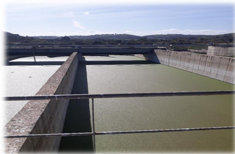
Figure_III_04 : bassin d'aération
