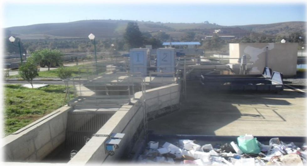
Figure_III_01 : Dégrillage grossier.
