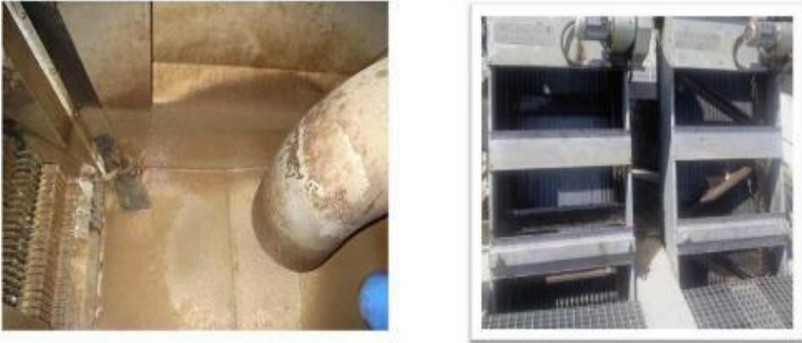
**Figure III.2 :** Photo d'une grille grossière et fine
