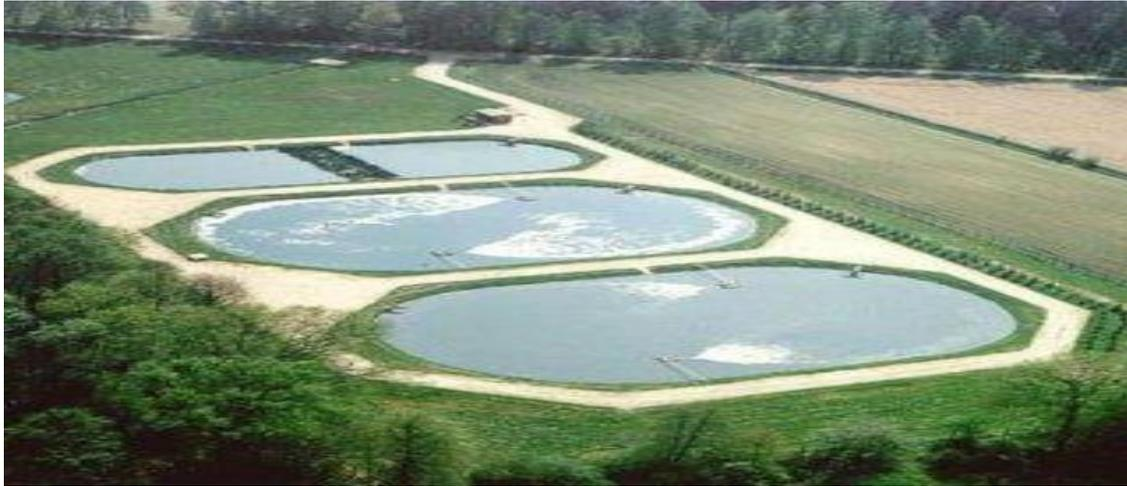
**Figure III.7 : Lagunage aéré**
