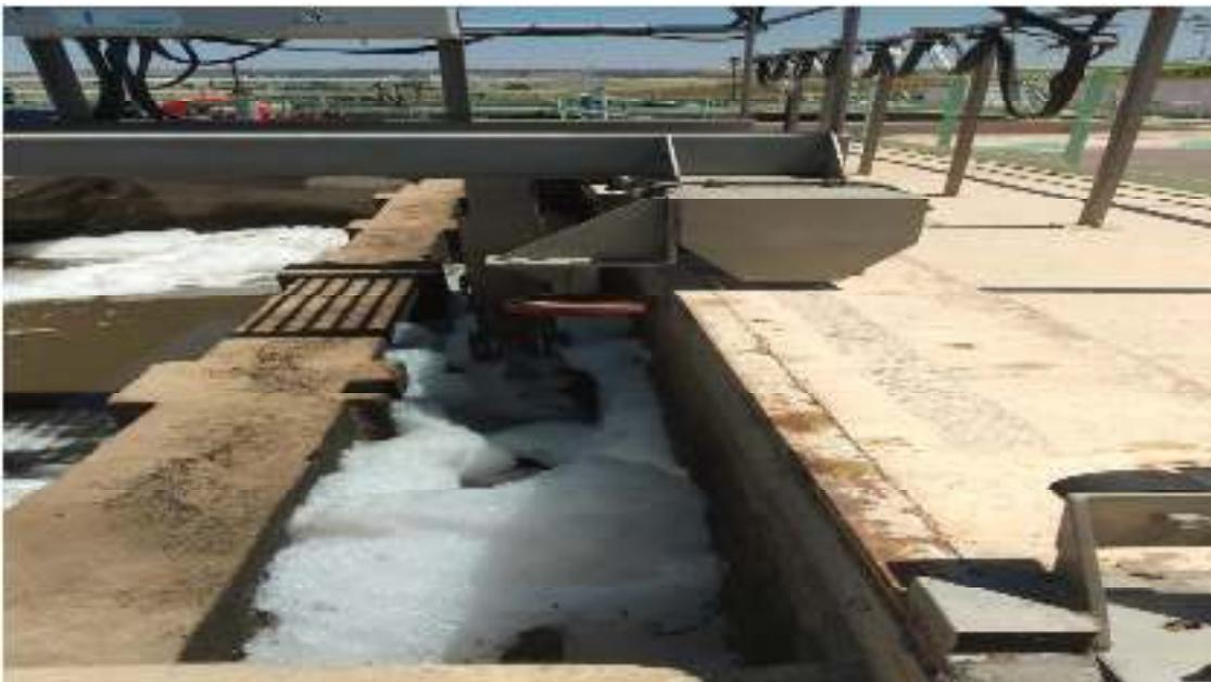
Figure II.5: Déshuileur (Mr. BOUCELHA M Mr. HIDRA H 2018 – 2019)
