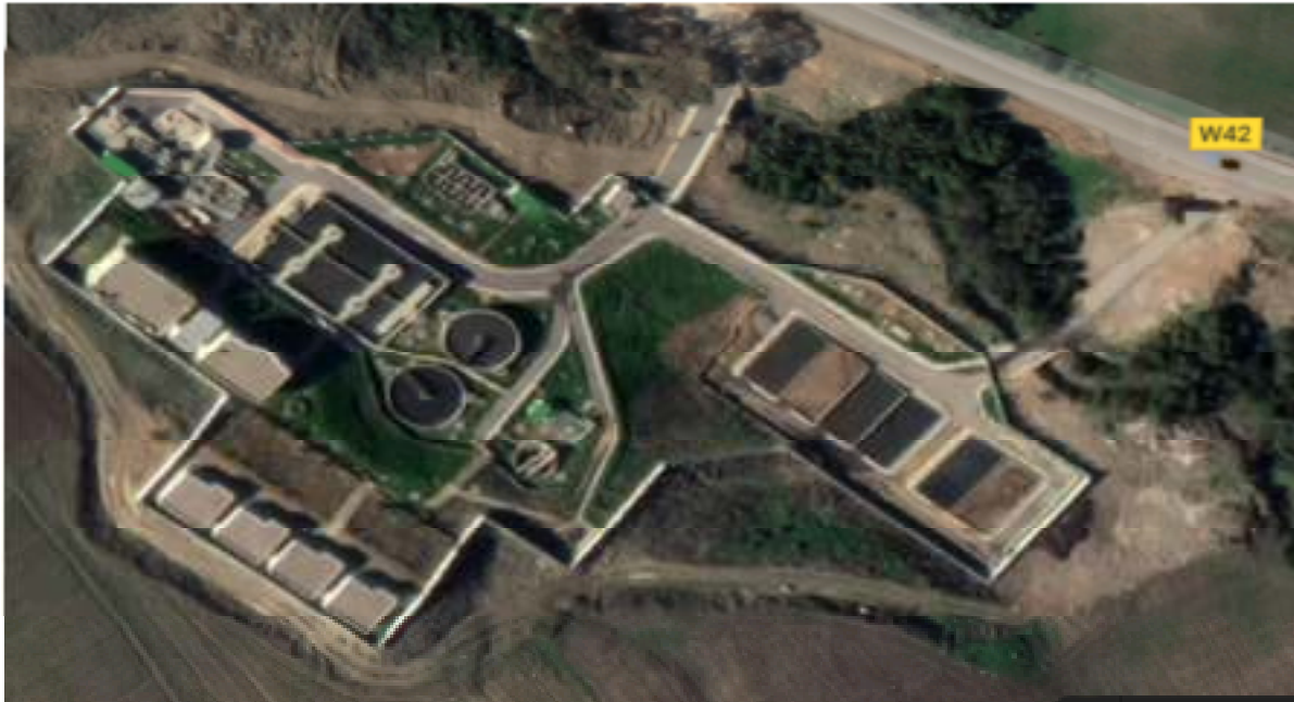
Figure .I.18: vue aérienne de la station d'épuration de Sidi Ali ( Source :Google earth)
