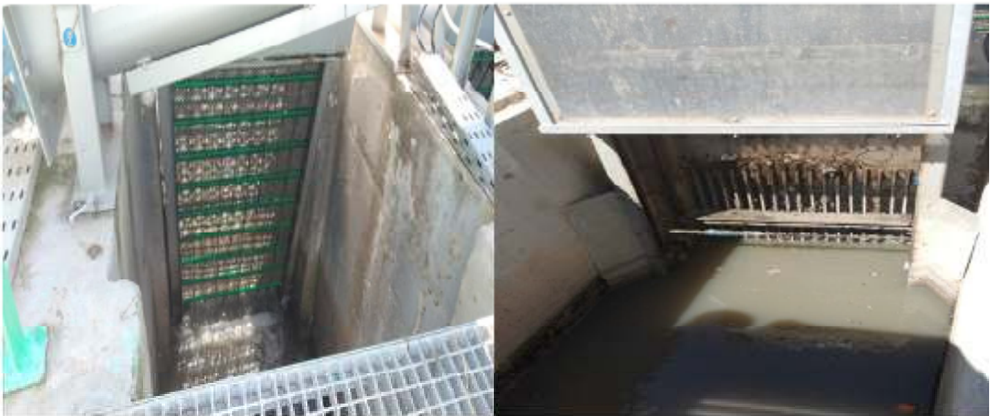
Figure II.3: Dégrilleur fin et grossier. (Mr. BOUCELHA M Mr. HIDRA H 2018 – 2019)
