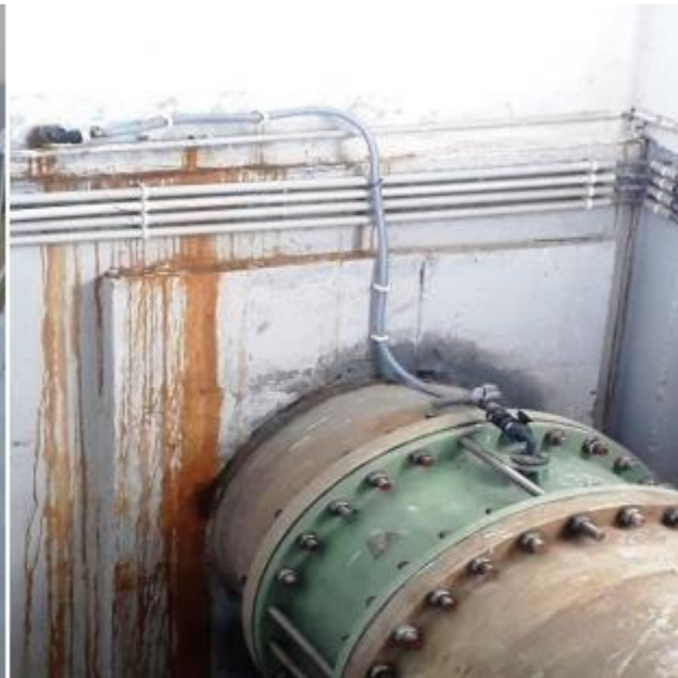
Figure IV- 9 Les mélangeurs statiques de coagulation-floculation
