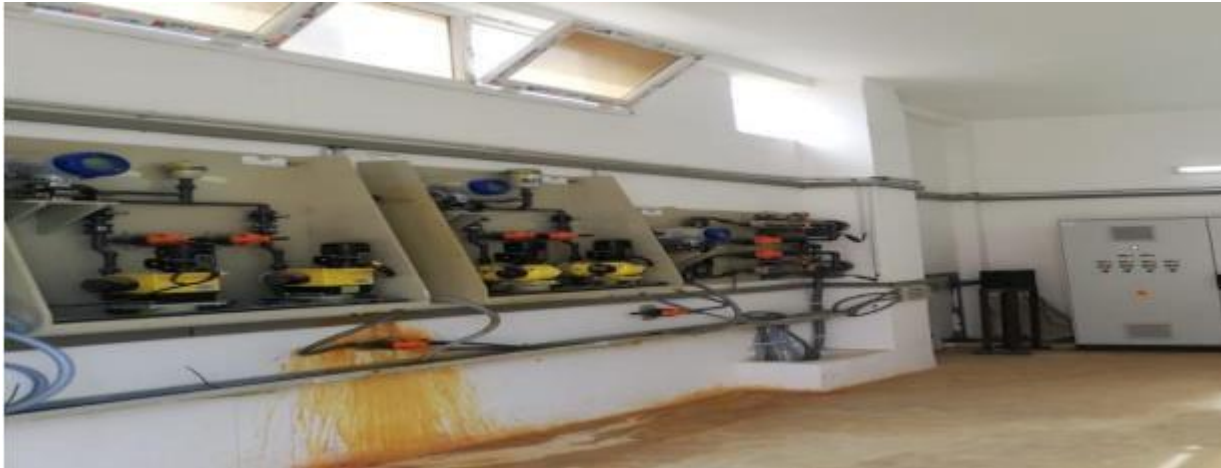
Figure IV- 11 Les pompes doseuses
