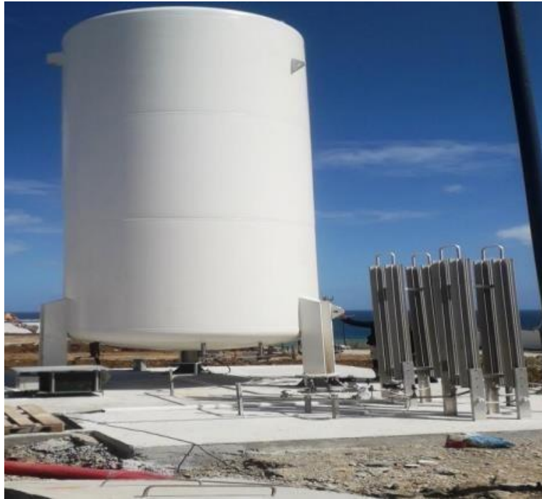
Figure IV- 20 Le système de stockage de CO2
