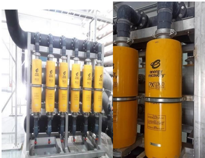
Figure IV- 17 Echangeur de pression
