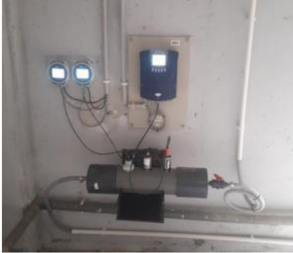
Figure IV- 8 Capteur chlorophylle, MES et PH Figure IV- 7 Capteurs T, Conductivité et HC
