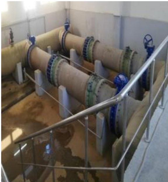
Figure IV- 9 Les mélangeurs statiques de coagulation-floculation
